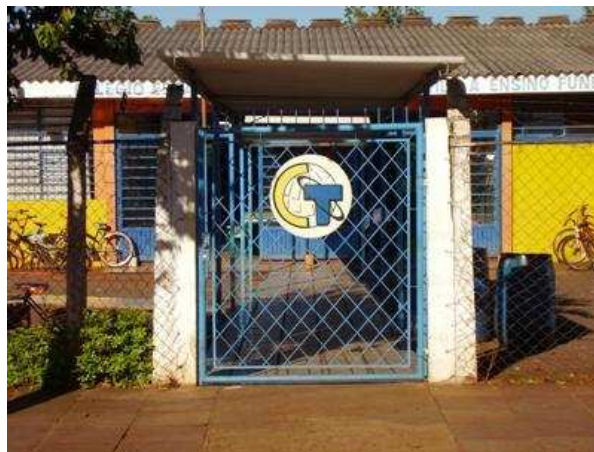
Figura 2: portão de entrada 2
