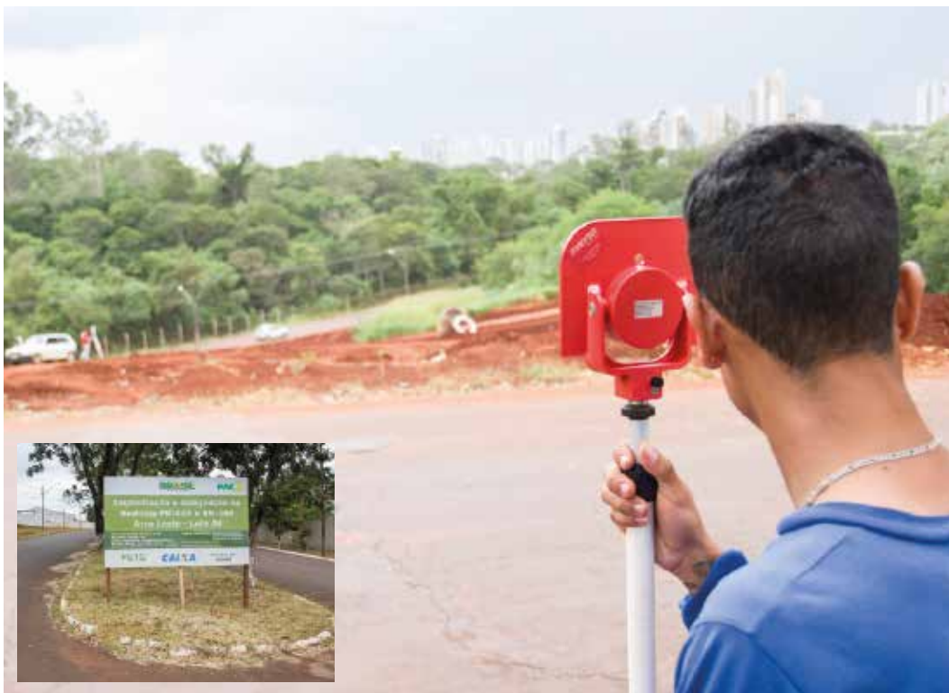
O Arco Leste em obras na altura da Avenida das Américas: projeto que liga a PR-445 à BR-369 promete desafogar o tráfego e atrair investimentos para aquela e outras regiões da cidade
