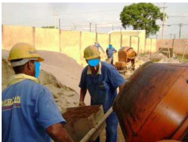
Figura 12: Profissional operador de betoneira atuando de forma errada.
