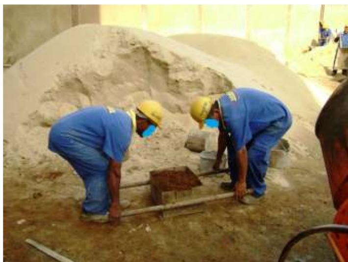
Figura 11: Profissional operador de betoneira atuando de forma errada.
