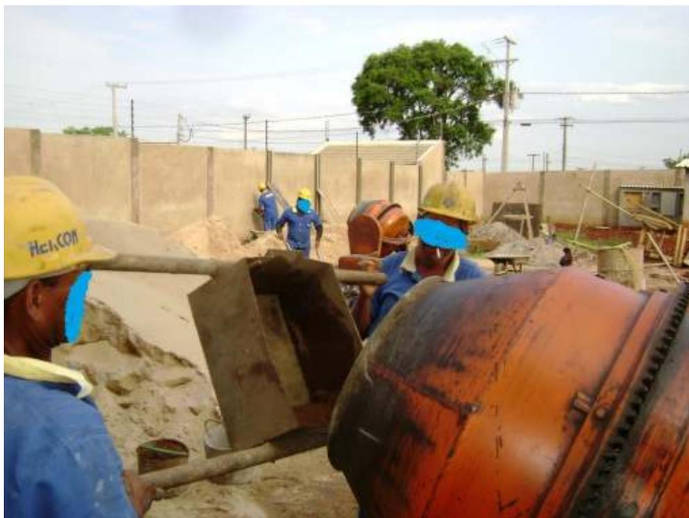
Figura 13: Profissional operador de betoneira atuando de forma errada.
