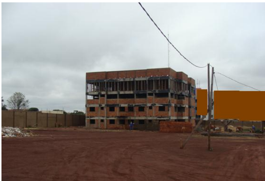
Figura 19 - Vista Frontal da Obra Fonte: Edilene Cristina Gribeler, 2012
