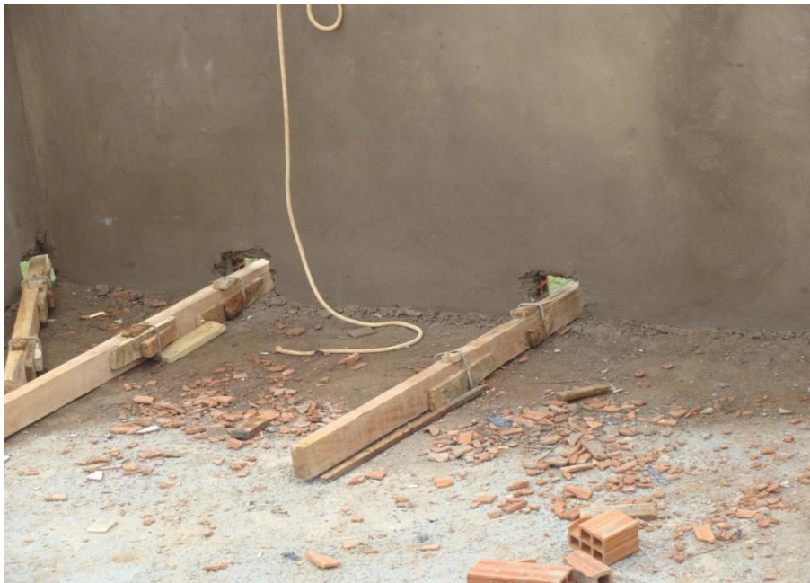
Figura 26 - Balança Para Montagem do Andaime em Madeira Fonte: Edilene Cristina Gribeler, 2012
