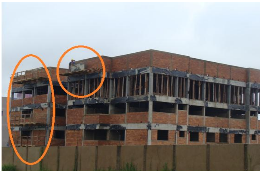
Figura 20 - Montagem de Andaimos em Madeira Fonte: Edilene Cristina Gribeler, 2012
