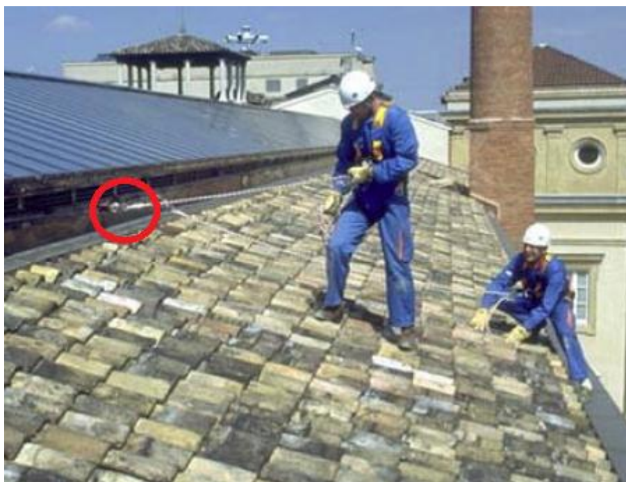
Figura 15 – Cabo-guia Fixado à Estrutura Definitiva Fonte: Pampalon, 2008
