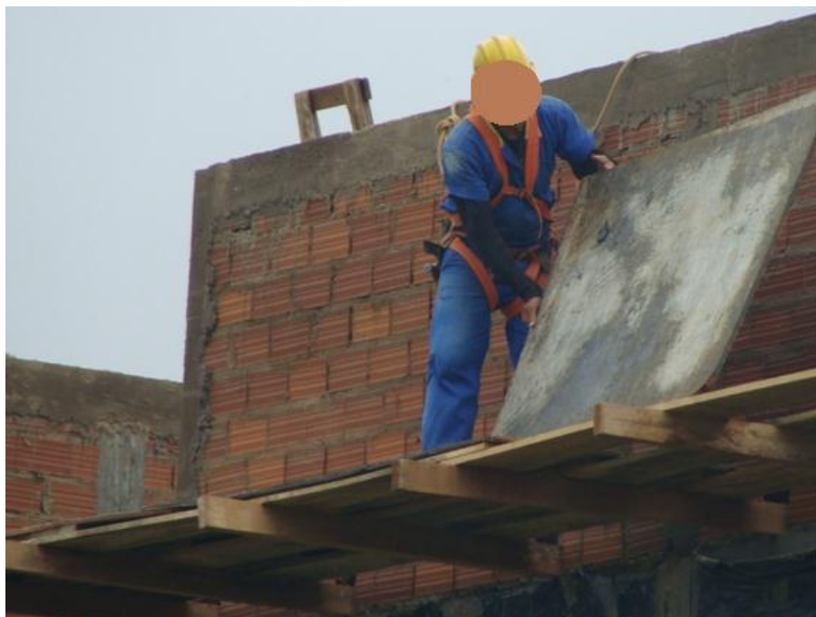
Figura 23 - Montagem do Andaime em Madeira Fonte: Edilene Cristina Gribeler, 2012
