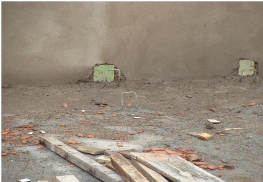
Figura 25 - Pinos para Montagem da Balança Para Andaime Fonte: Edilene Cristina Gribeler, 2012
