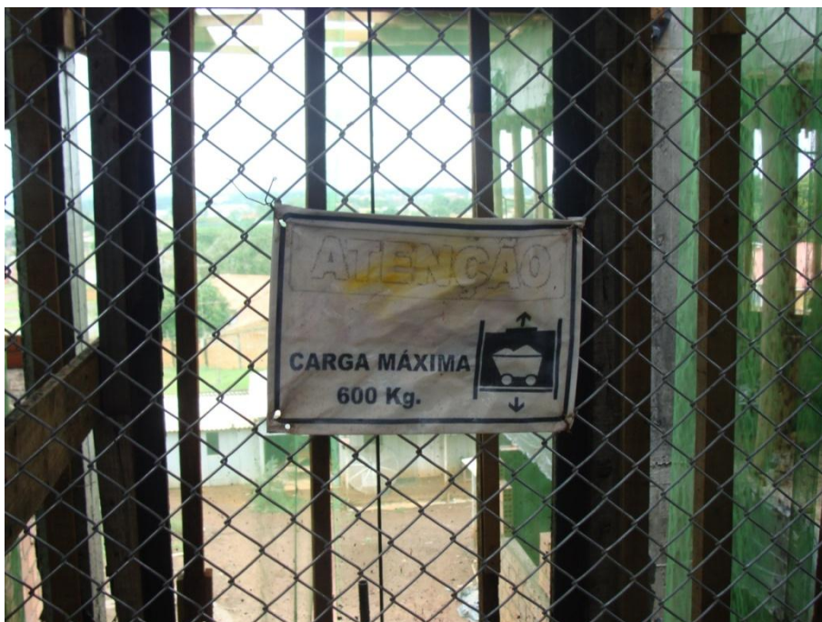
Figura 32 - Proteção em Vão do Elevador Placa de Sinalização Fonte: Edilene Cristina Gribeler, 2012
