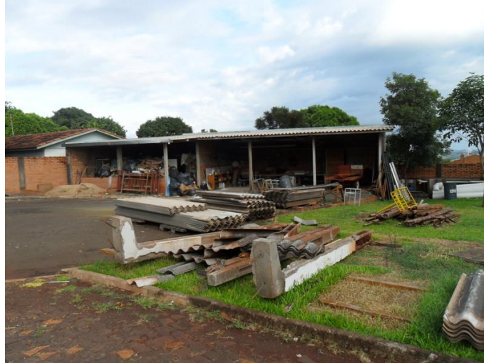
Fotografia 25: Área externa de trabalho da Divisão de Manutenção.
