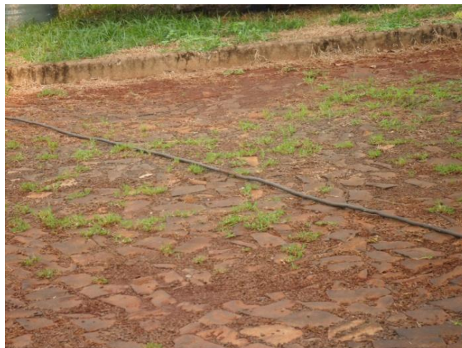
Fotografia 22: extensão elétrica segue da área do bloco até a área externa da Divisão de Manutenção.
