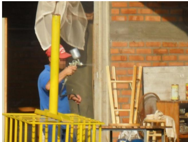
Fotografia 36: trabalhador pintando móvel sem o uso dos EPI's.
