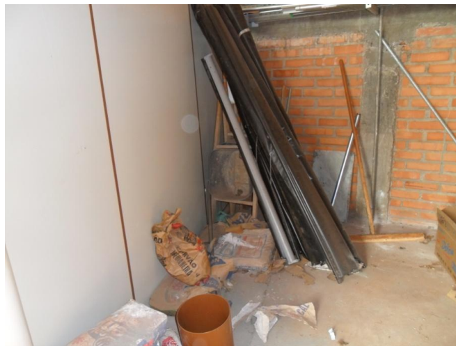
Fotografia 31: área externa de trabalho da Divisão de Manutenção.
