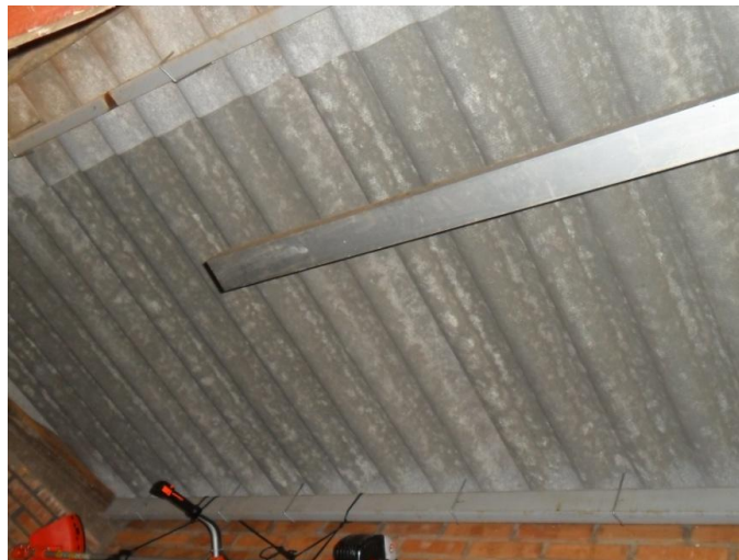
Fotografia 28: área de trabalho externa da Divisão de Manutenção.
