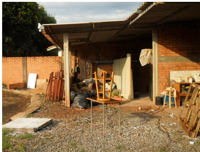
Fotografia 24: Área externa de trabalho da Divisão de Manutenção.
