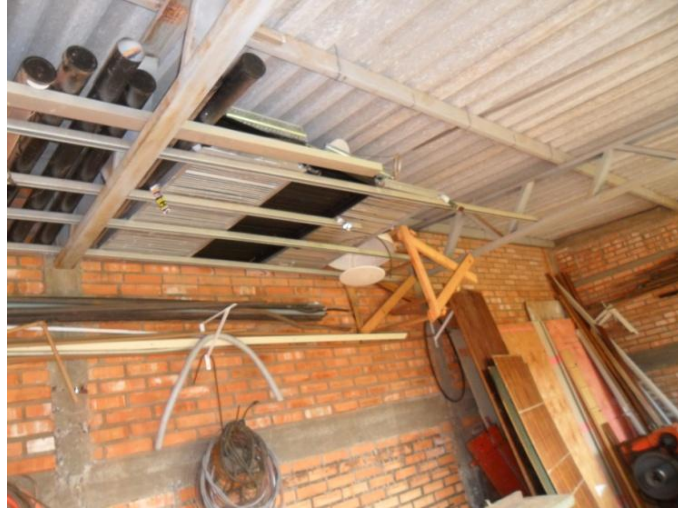
Fotografia 29: área de trabalho externa da Divisão de Manutenção.
