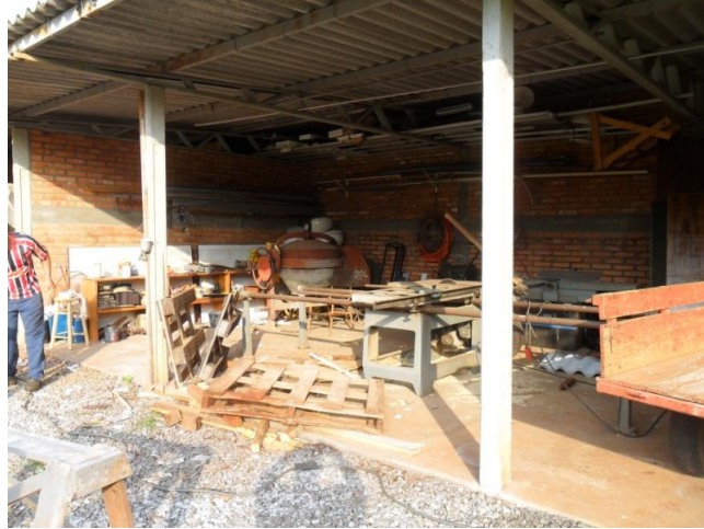
Fotografia 27: Área de trabalho externa da Divisão de Manutenção.
