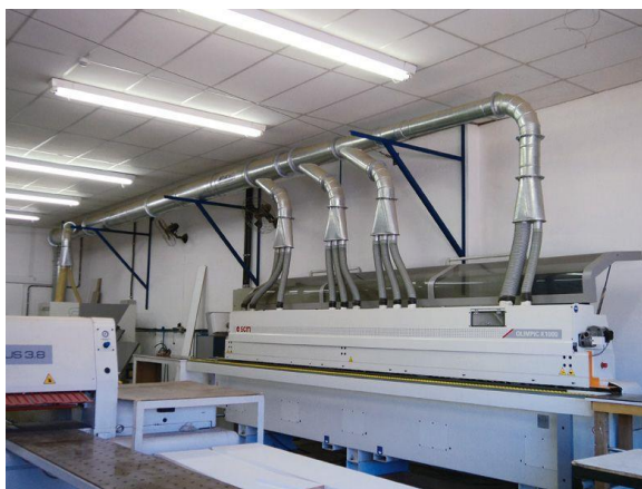
Figura 6 - Coletores de Pó Fonte: Emobile, 2018
