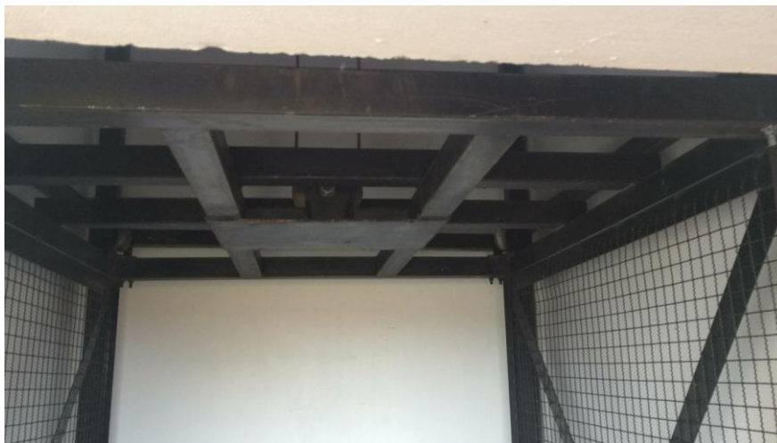
Fotografia 9 - Teto da Cabina do Elevador. Fonte: Autor (2018).
