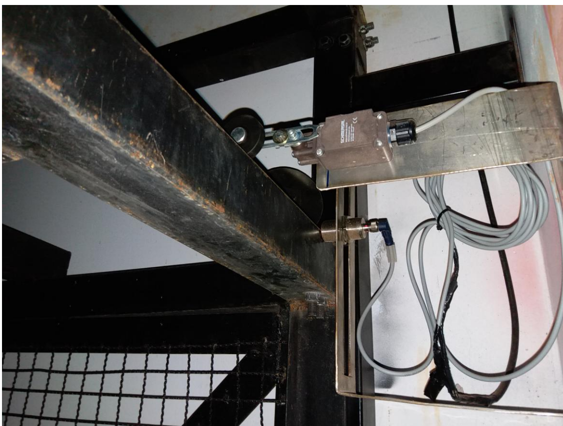
Fotografia 4 - Fim de Curso de Segurança e Sensor de Parada de Nível. Fonte: Autor (2018).
