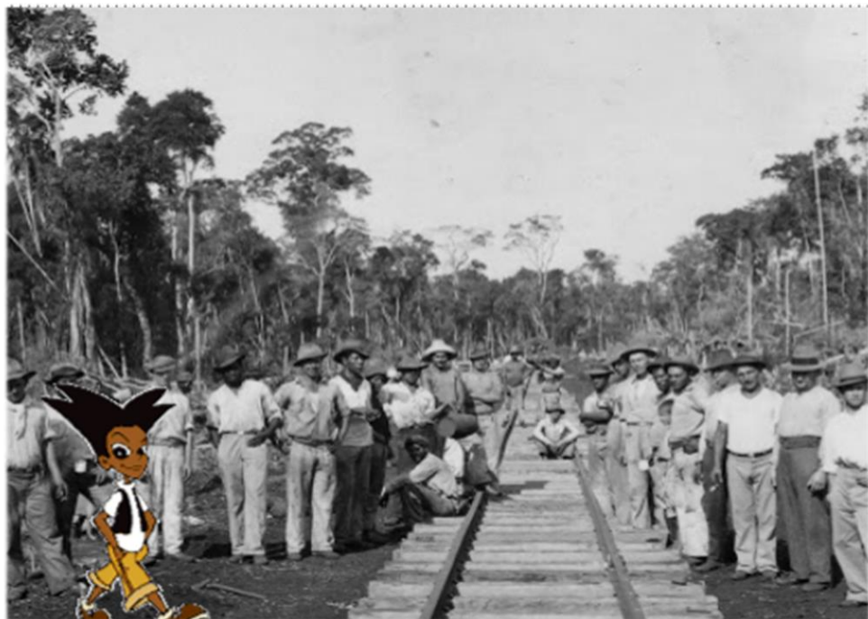
Figura 6: Construção da linha de trem
