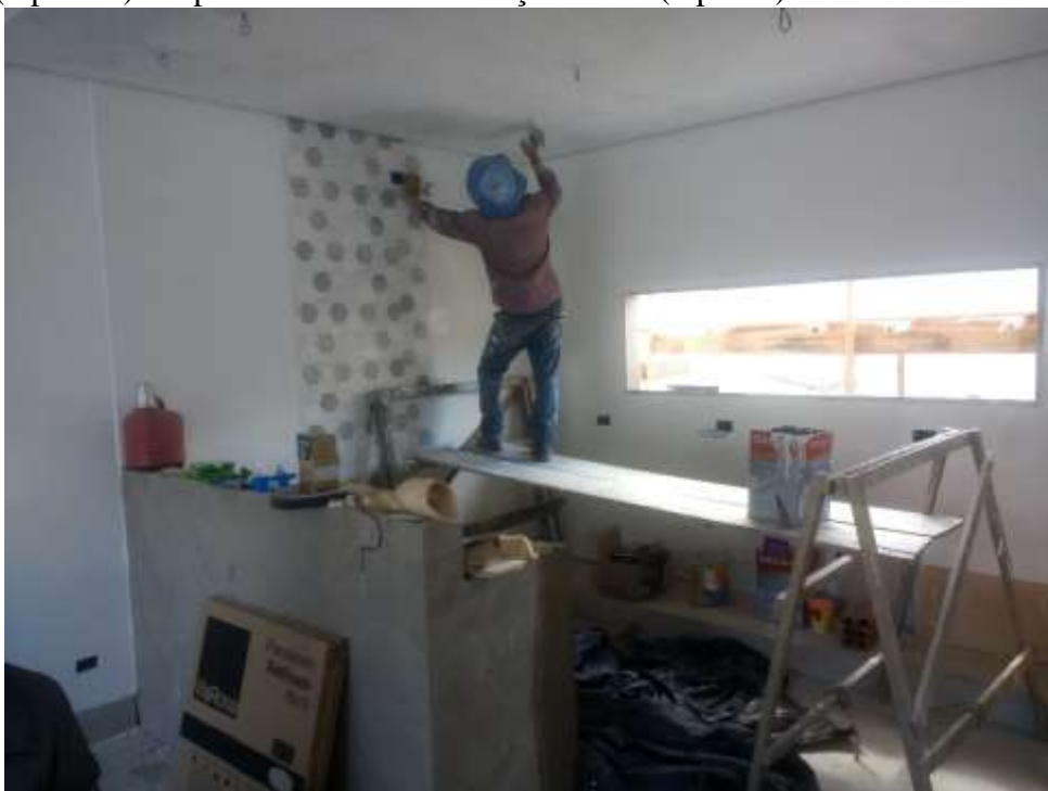
Fonte: O Autor (2018) Figura 4 – Emassamento
