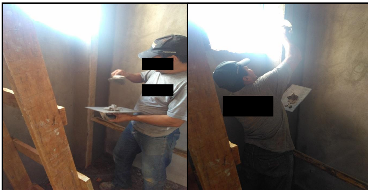
Fotografia 3 Aplicação do reboco à parede realizada pelo pedreiro.
