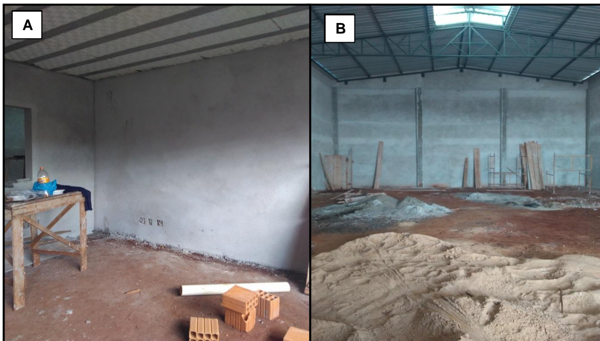
Fotografia 2 Vista interna dos setores do barracão: Escritório (A) e Depósito (B).
