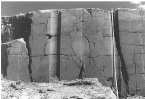
(a) Rocha arenítica fraturada. Fonte: Dietrich et al. (2005).
