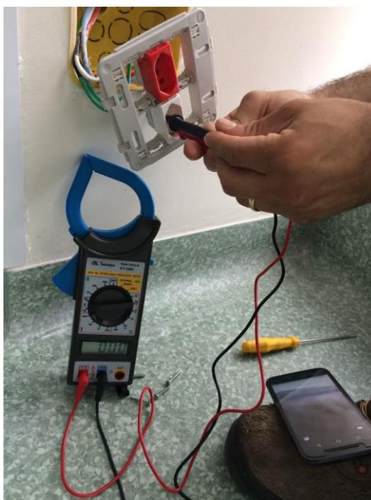
**Figura 15 - Tomada ao lado do leito 4 - UTI Pediátrica – Verificação de tensão.**
