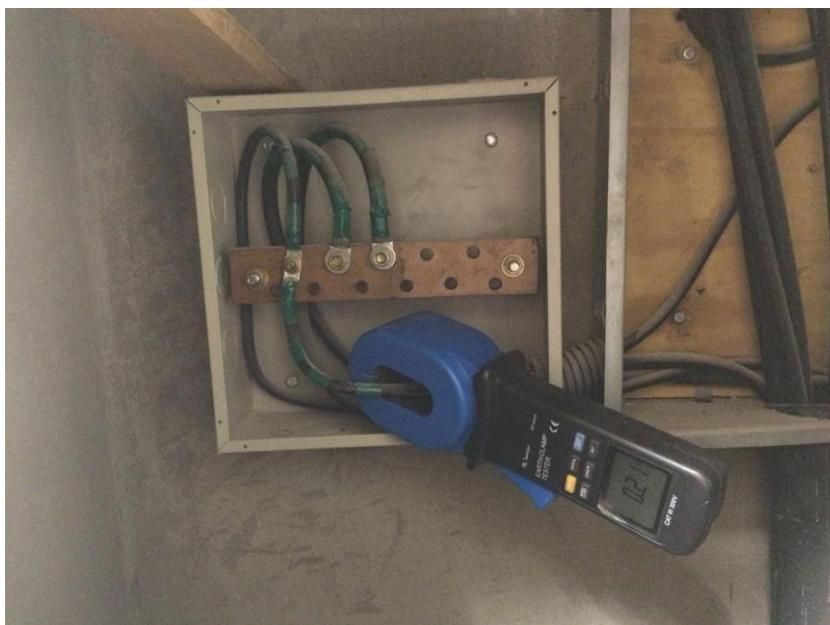
**Figura 16 - Barramento de Terra da UTI Pediátrica - HCL.
