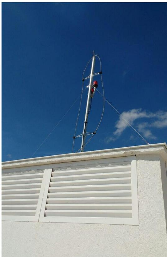
**Figura 17 - Para Raios Tipo Franklin - HCL.
