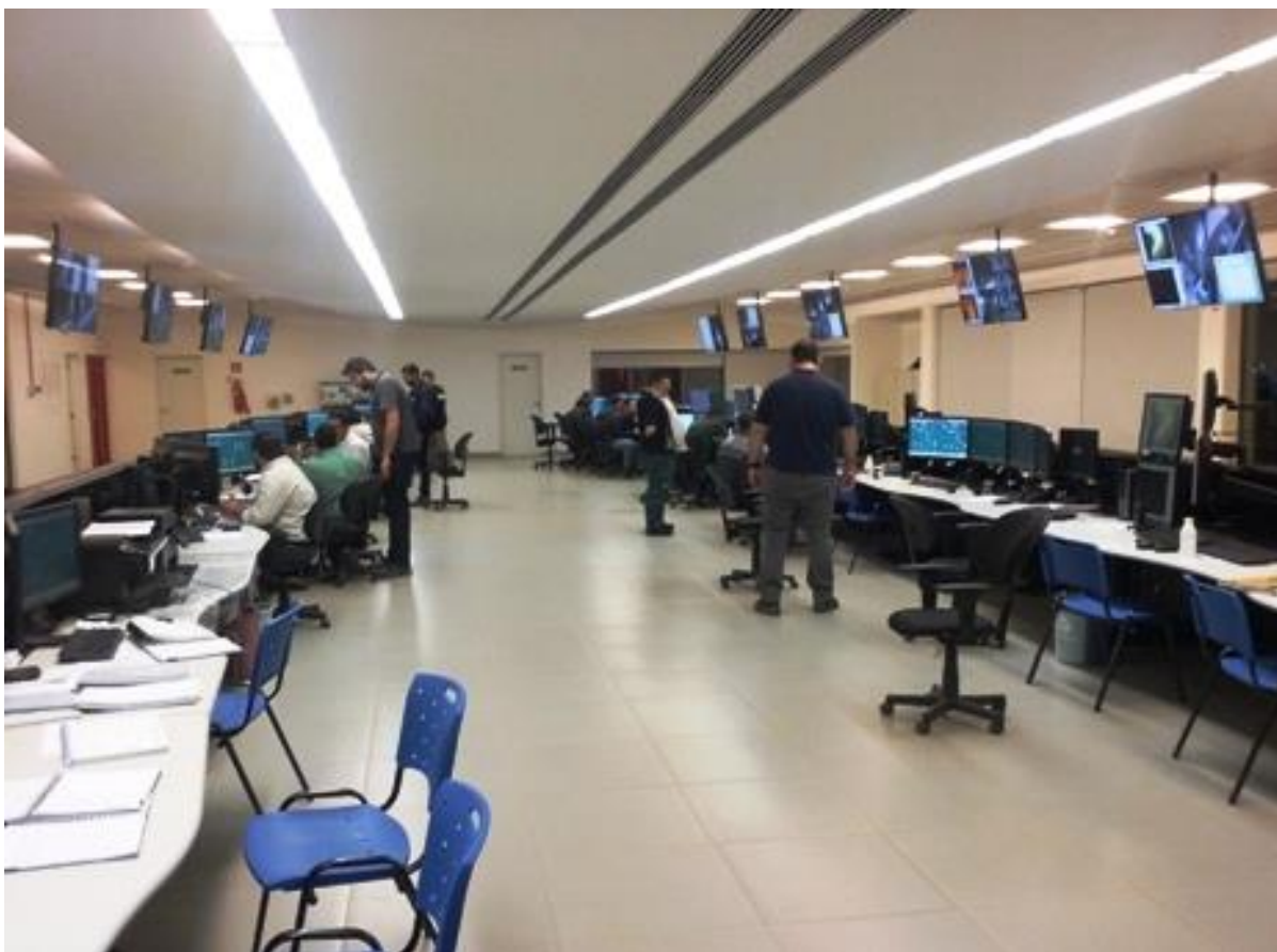
Figura 7 - Sala de controle central Fonte: O autor (2016)
