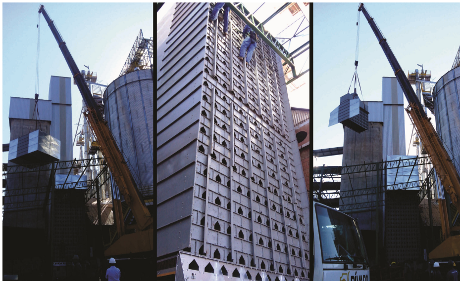
Figura 17 – Montagem de secador na obra Fonte: Autoria própria (2017)
