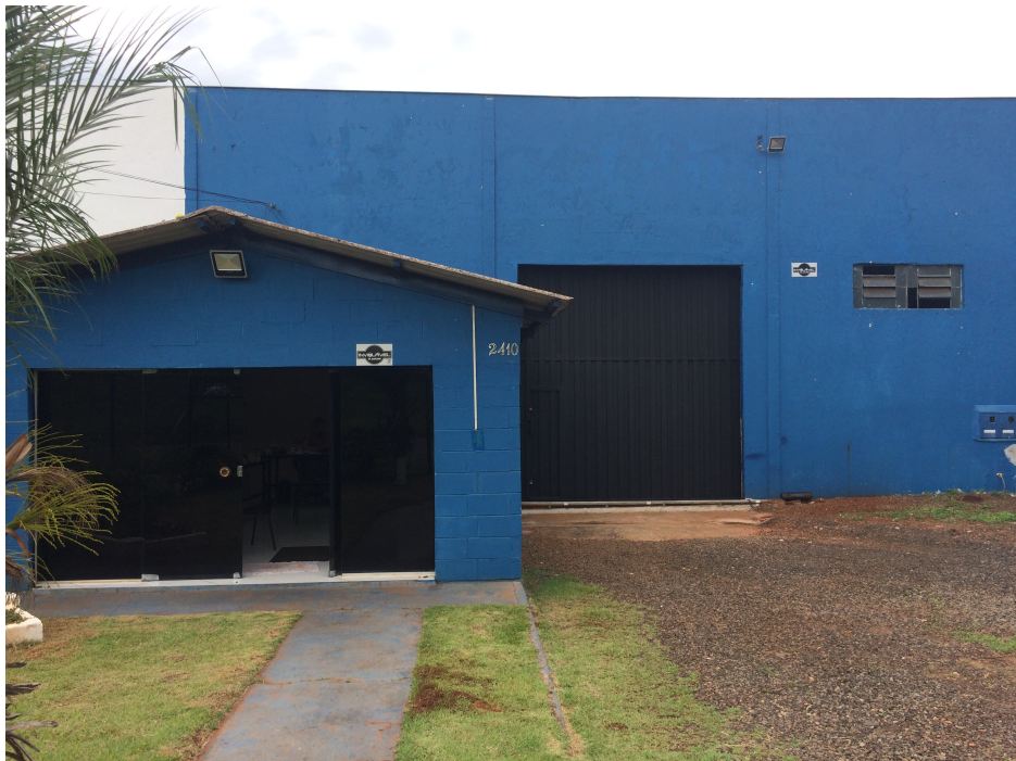
Figura 14 – Fachada Fonte: Autoria própria (2017)
