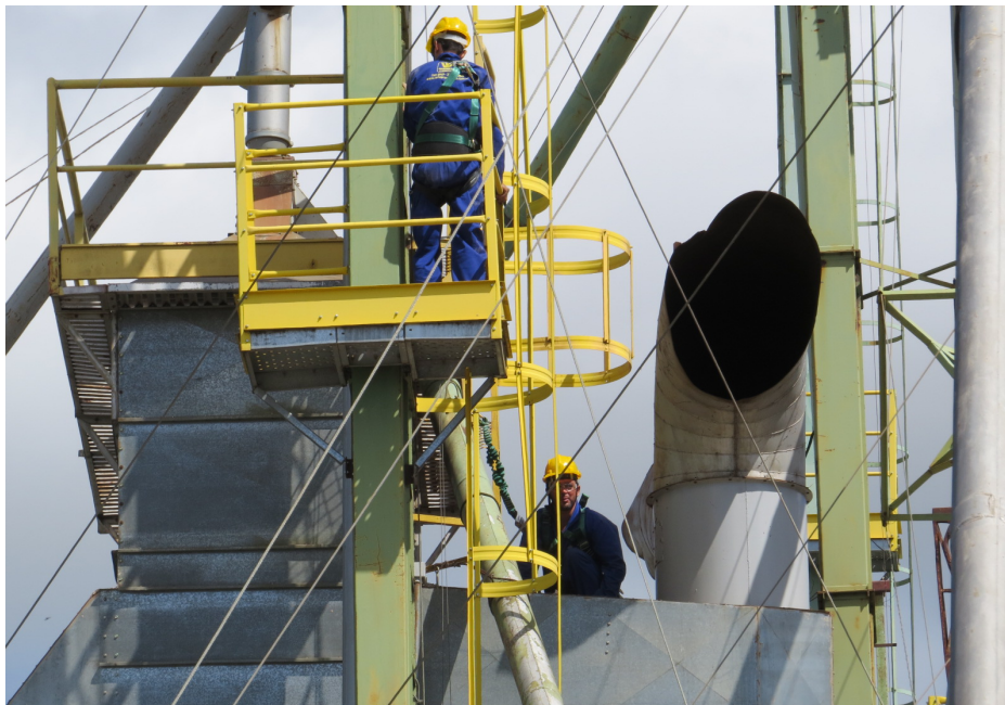
Figura 21 – Montagem de secador Fonte: Autoria própria (2017)
