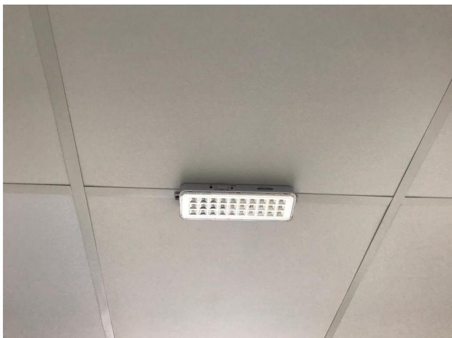
Imagem 17 - Iluminação de emergência. Fonte: arquivo próprio. 2017.
