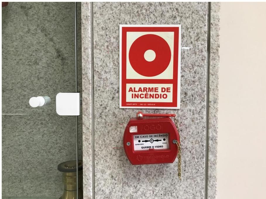
Imagem 9 - Acionamento de emergência. Fonte: arquivo próprio. 2017.
