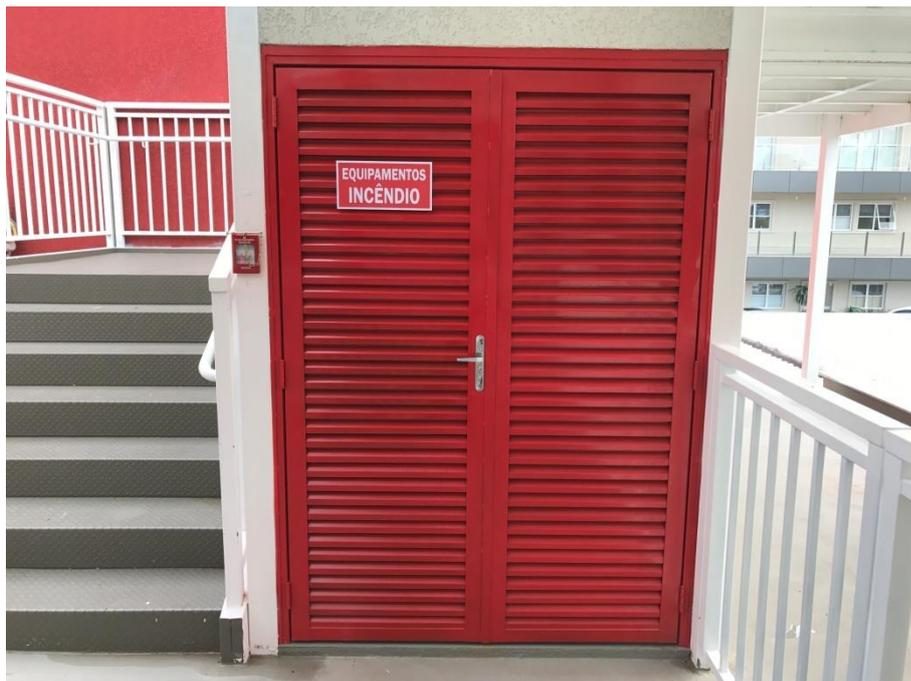
Imagem 19 - Abrigo isolado com paramentação dos bombeiros. Fonte: arquivo próprio. 2017.
