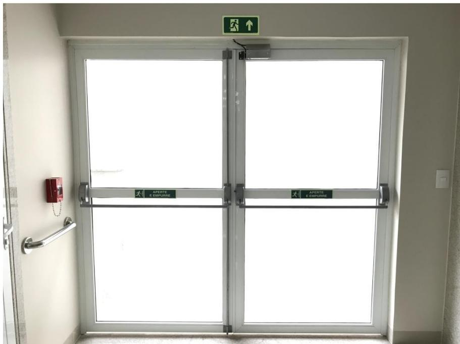
Imagem 15 - Barra antipânico instalado em porta. Fonte: arquivo pessoal. 2017.
