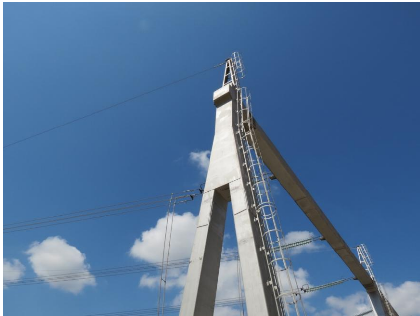
Figura 1 - Chegada de cabo OPGW ao topo do pórtico Fonte: Autoria própria.
