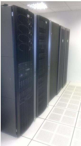
Figura 15 - Racks dispostos sobre o piso elevado
