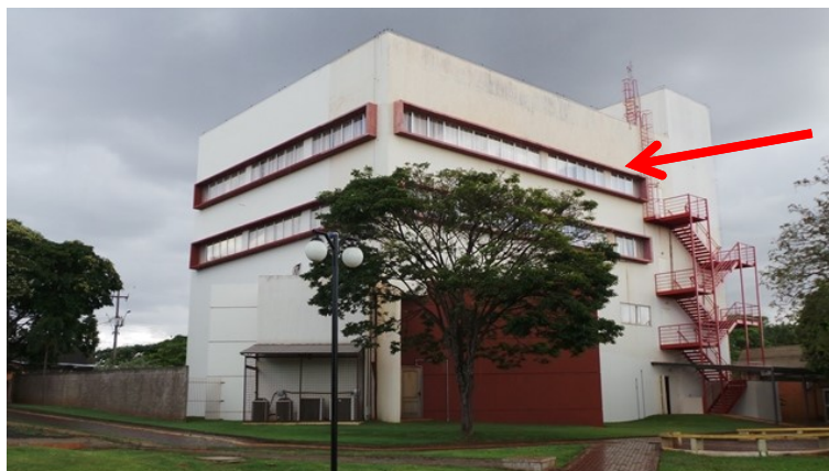
Figura 51 – Fotografia – Fachada 3 e 4 da biblioteca de Medianeira Fonte: Autoria própria
