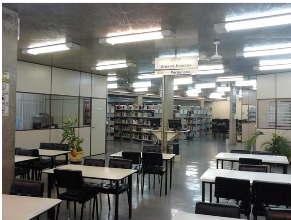
Figura 42 – Fotografia – Ofuscamento provocado por luminárias sem defletores – biblioteca de Cornélio Procópio Fonte: Autoria própria
