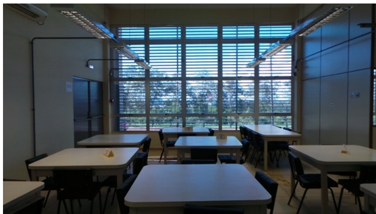
Figura 57 – Fotografia – Proteção solar externa da biblioteca de Dois Vizinhos Fonte: Autoria própria
