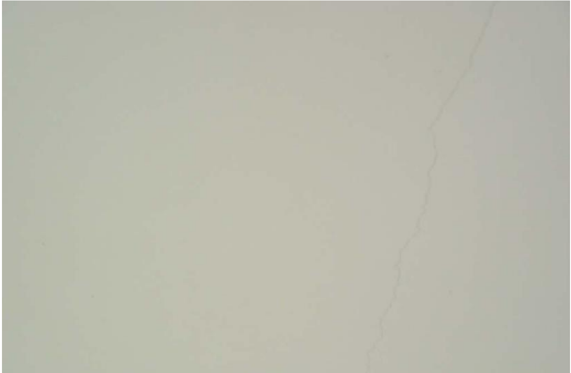
FIGURA 22 – FISSURA 8 NA FACE INFERIOR DA SACADA Fonte: AUTOR, (2016)
