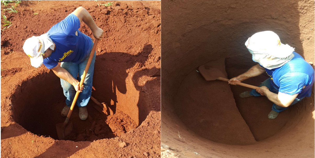
Figura 14: Escavação do poço de coleta de solo indeformada.
