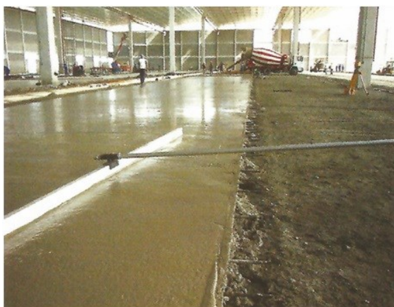
Figura 10 – Rodo de corte para acabamento superficial Fonte: Rodrigues, Faria e Silva (2015)
