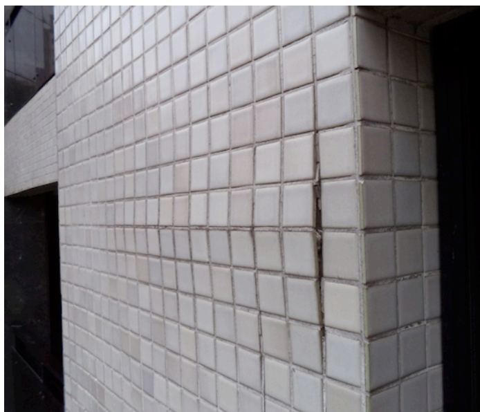
Figura 15 - Estufamento de revestimento cor clara
