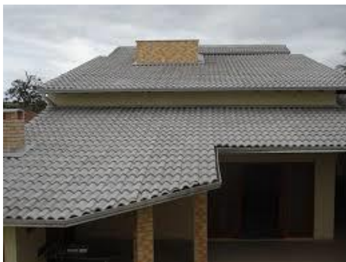
Figura 4 – Telhado com telhas cerâmicas Fonte: www.deolhonaobra.com.br
