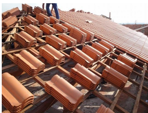
Figura 1 – Telhado com telhas de barro Fonte: www.ecomadeiras.com.br
