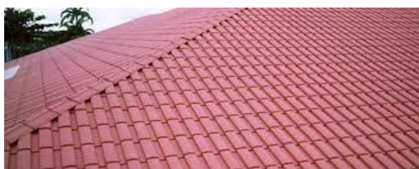
Figura 7 – Telhado com telhas de plástico Fonte: www.telhadosconfianca.com.br
