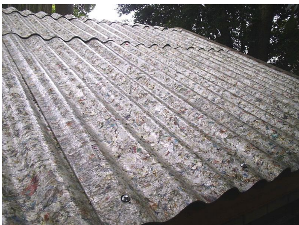
Figura 9 – Telhado com telhas de material reciclável Fonte: www.ecopex.com.br
