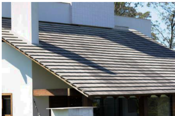
Figura 5 – Telhado com telhas de concreto planas Fonte: www.casadastelhasbnu.com.br
