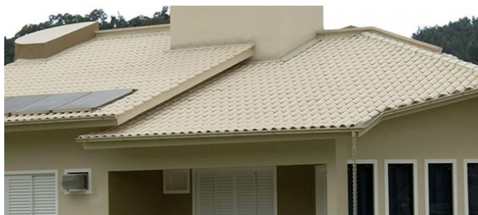
Figura 3 – Telhado com telhas cerâmicas Fonte: www.damale.com.br
