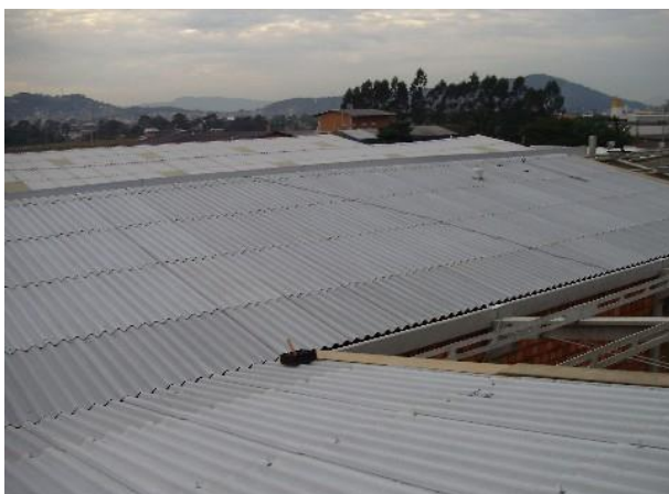
Figura 10 – Telhado com telhas de fibrocimento Fonte: www.cobervale.com.br
