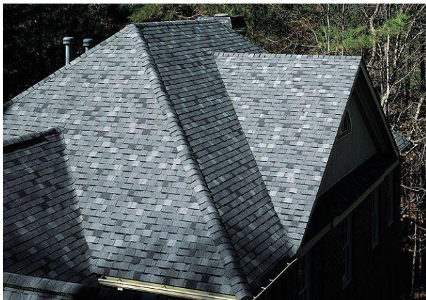
Figura 8 – Telhado com telhas de asfalto Fonte: www.telhados.srv.br
