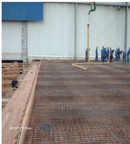
FIGURA 3 – CONCRETAGEM LAJE ESTRUTURAL
