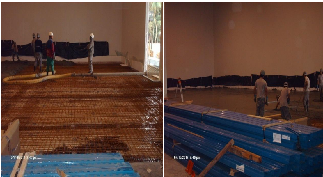
FIGURAS 11 e 12 – PREPARO CONCRETAGEM PISO OPERACIONAL
