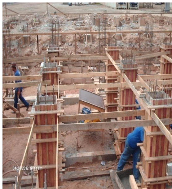
FIGURA 2 – MONTAGEM FÔRMAS PILARES ESTRUTURAIS DA LAJE
