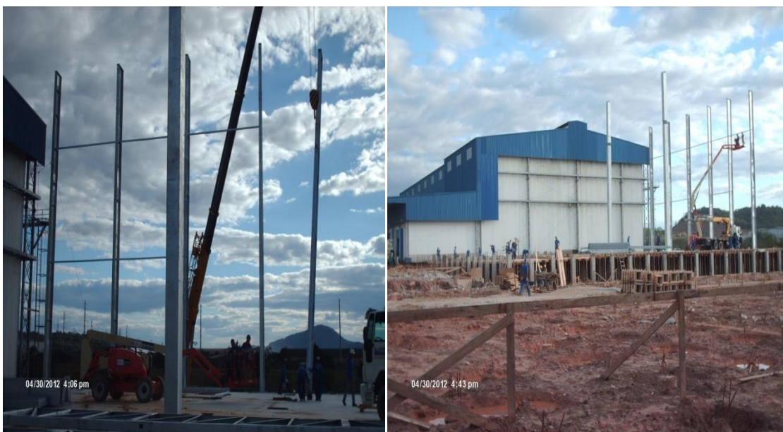
FIGURAS 5 e 6 – MONTAGEM ESTRUTURA METÁLICA
