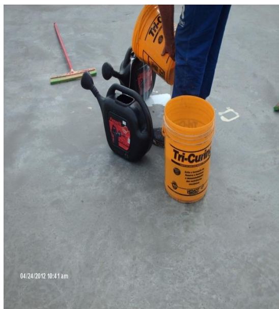
FIGURA 4 - APLICAÇÃO DE CURA QUÍMICA
