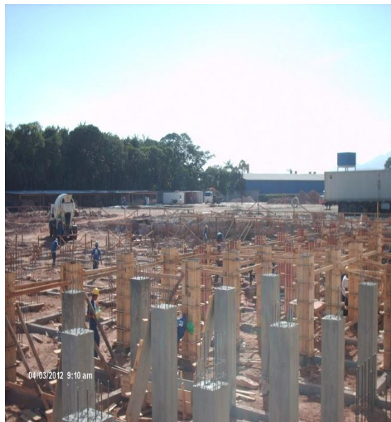
FIGURA 1 – PILARES ESTRUTURAIS DA LAJE
