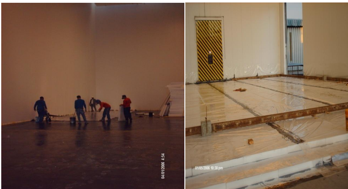
FIGURAS 9 e 10 – MONTAGEM ISOLAMENTO PISO OPERACIONAL
