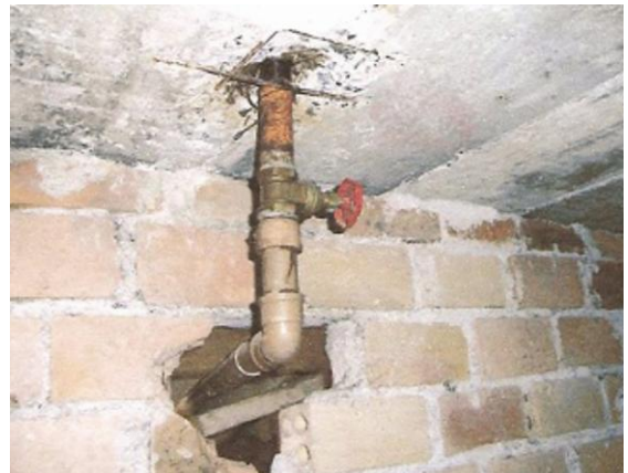
Figura 4.24 - 4.25 – Furos nas tubulações e armaduras expostas – Bloco B. Fonte: Acervo pessoal (2014).
