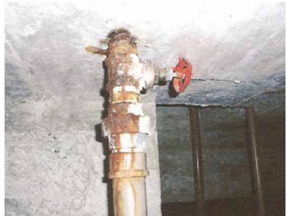
Figura 4.26 - 4.27 – Flanges e registros em processo de deterioração – Bloco C. Fonte: Acervo pessoal (2014).
