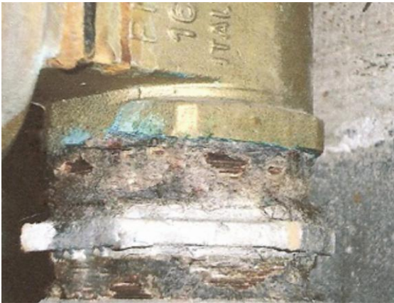
Figura 4.24 - 4.25 – Furos nas tubulações e armaduras expostas – Bloco B. Fonte: Acervo pessoal (2014).
