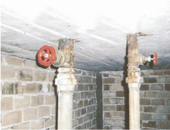
Figura 4.22 - 4.23 – Flanges e registros em processo de deterioração – Bloco B. Fonte: Acervo pessoal (2014).
