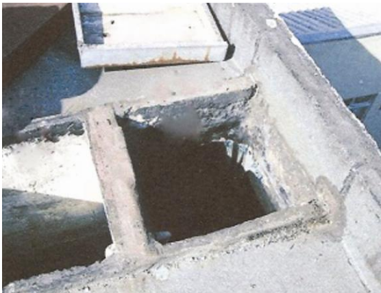
Figura 4.12 – 4.13 – Tampas de madeira com revestimento metálico e tampa de concreto – Bloco A. Fonte: Acervo pessoal (2014).
