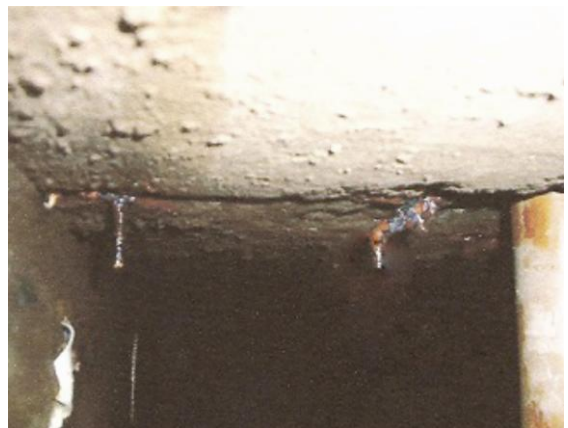
Figura 4.34 - 4.35 – Corrosão interna e externa da cisterna. Fonte: Acervo pessoal (2014).
