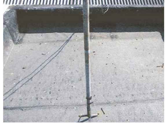
Figura 4.10 – 4.11 – Instalação inadequada do para raios e ausência de rufos – Bloco A. Fonte: Acervo pessoal (2014).
