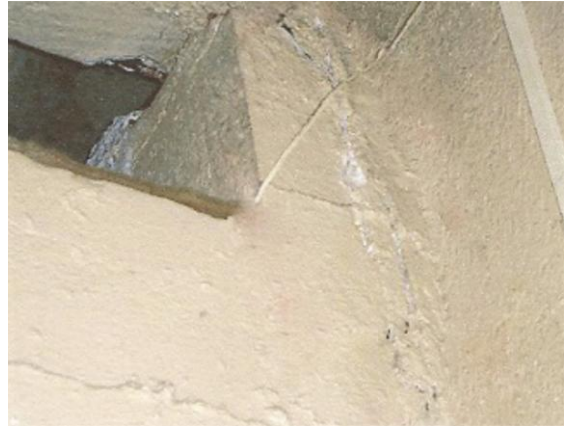
Figura 4.30 - 4.31 – Fissuras de deslocamento. Fonte: Acervo pessoal (2014).
