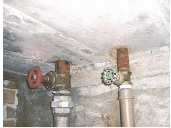
Figura 4.22 - 4.23 – Flanges e registros em processo de deterioração – Bloco B. Fonte: Acervo pessoal (2014).
