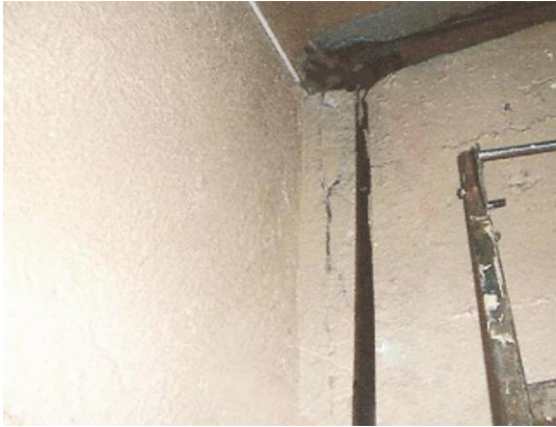
Figura 4.30 - 4.31 – Fissuras de deslocamento. Fonte: Acervo pessoal (2014).
