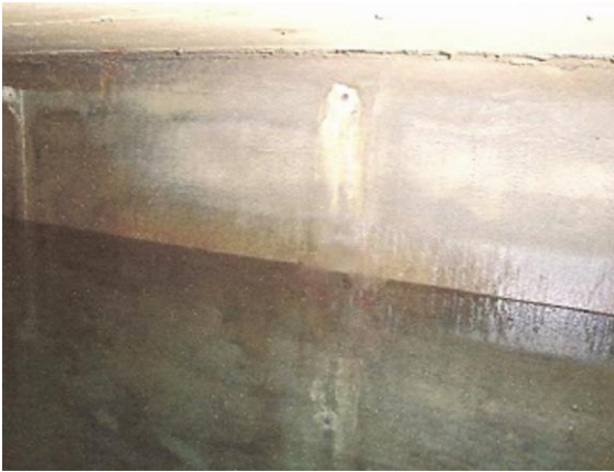
Figura 4.32 - 4.33 – Extrema deterioração da manta asfáltica. Fonte: Acervo pessoal (2014).
