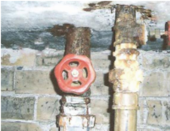
Figura 4.19 – 4.20 – Flanges e registros em processo de deterioração – Bloco A. Fonte: Acervo pessoal (2014).
