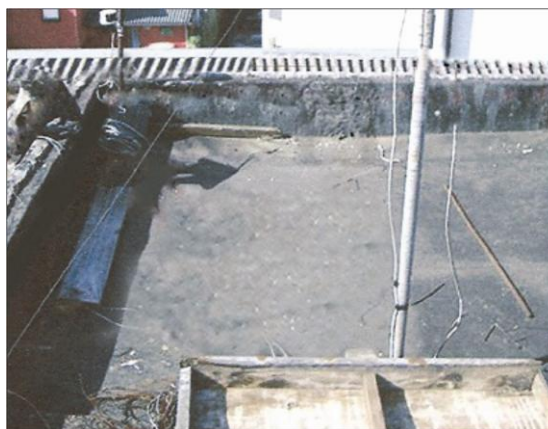
Figura 4.14 – Lajes de cobertura do Bloco B. Fonte: Acervo pessoal (2014).
