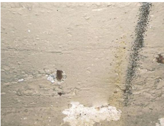
Figura 4.34 - 4.35 – Corrosão interna e externa da cisterna. Fonte: Acervo pessoal (2014).
