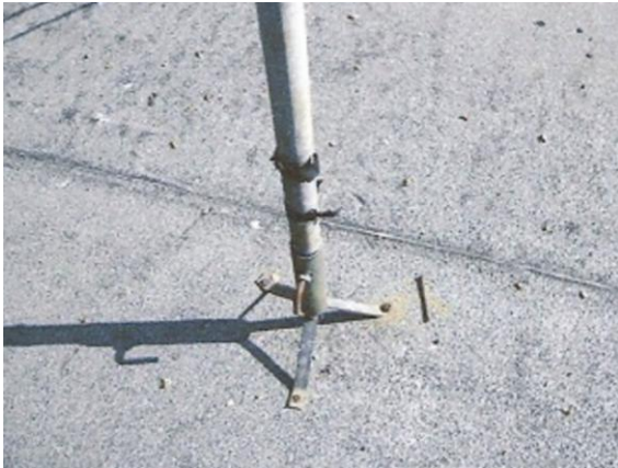
Figura 4.10 – 4.11 – Instalação inadequada do para raios e ausência de rufos – Bloco A. Fonte: Acervo pessoal (2014).
