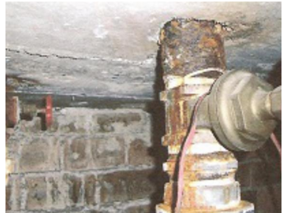
Figura 4.19 – 4.20 – Flanges e registros em processo de deterioração – Bloco A. Fonte: Acervo pessoal (2014).
