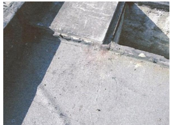
Figura 4.12 – 4.13 – Tampas de madeira com revestimento metálico e tampa de concreto – Bloco A. Fonte: Acervo pessoal (2014).
