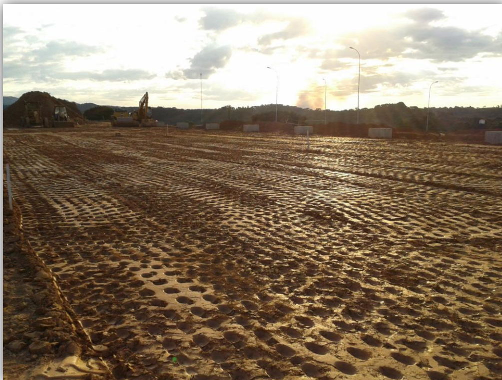
Fig. 33 - Compactação de subleito (Fonte: Própria)
