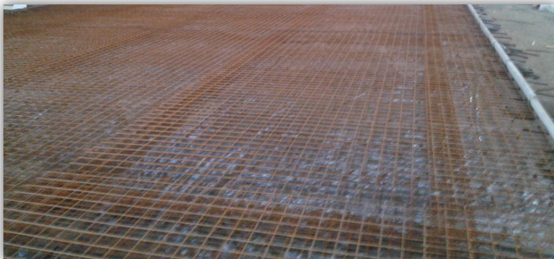
Fig. 42 – Transpasse de tela em duas malhas (notar área mais escura na sobreposição das telas). (Fonte: Própria).
