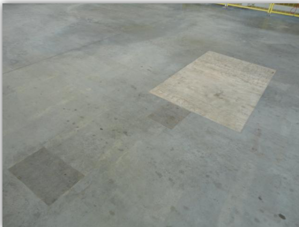
Fig. 74 - Pequenos e grande reparos de delaminação (Fonte: Própria)
