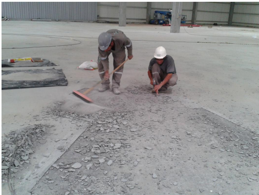
Fig. 79 – Detalhe da retirada do material não aderido com ferramentas manuais (Fonte: Própria)
