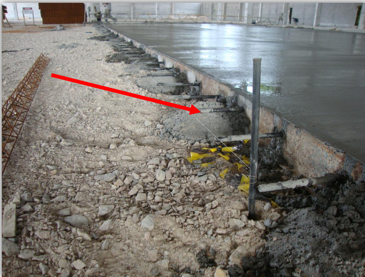
Fig. 47 - Alinhamento das BT posteriormente ao lançamento (Fonte: Própria)
