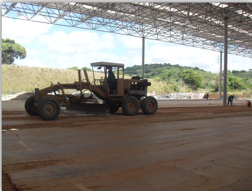
Fig. 36 - Execução de sub-base em solo cimento (Fonte: Própria)
