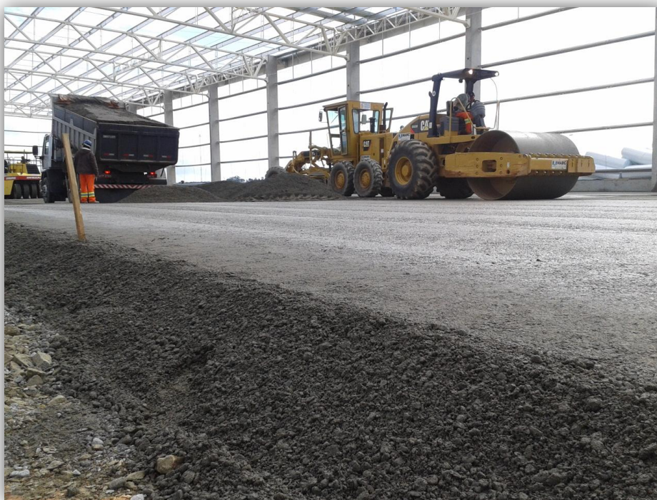
Fig. 35 - Execução de sub-base em BGTC (Fonte: Própria)
