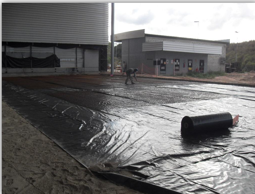
Fig. 38 - Colocação de barreira de vapor – filme de polietileno (Fonte: Própria)
