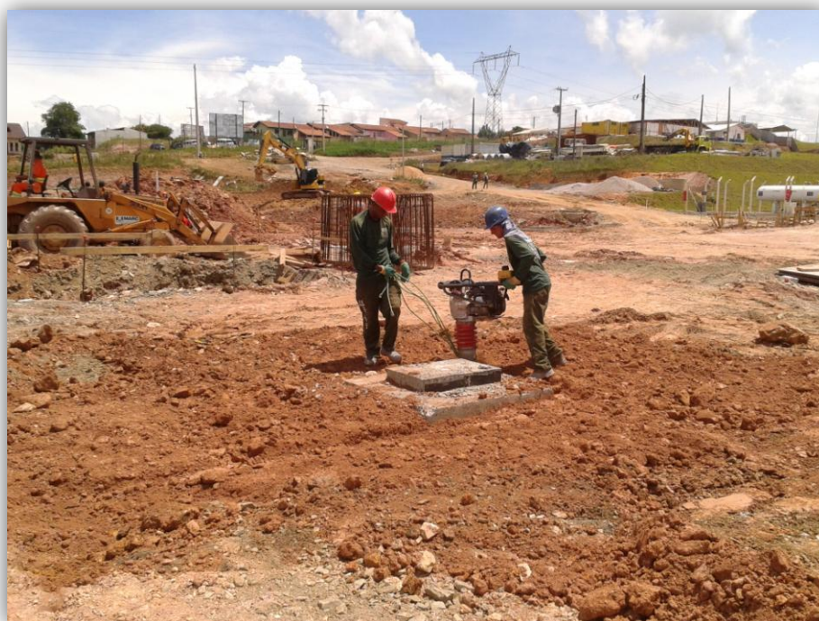
Fig. 32 - Recomposição bloco de fundação (Fonte: Própria)
