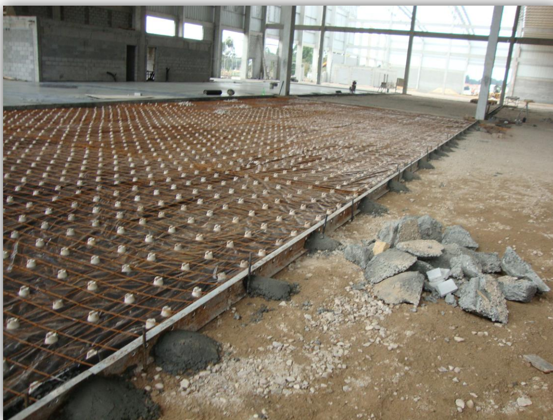
Fig 39. – Utilização de formas metálicas (travamento utilizando concreto). (Fonte: Própria)
