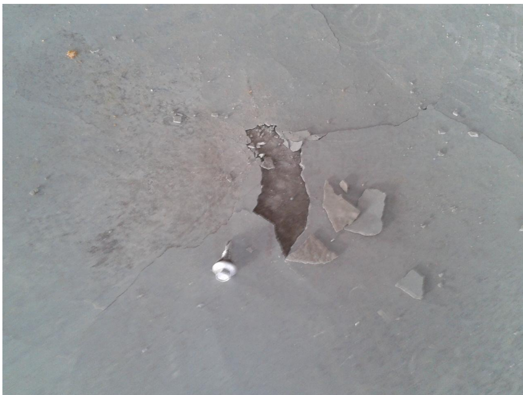
Fig. 77 – Primeiro aparecimento de área com fragmentos (Fonte: Própria)
