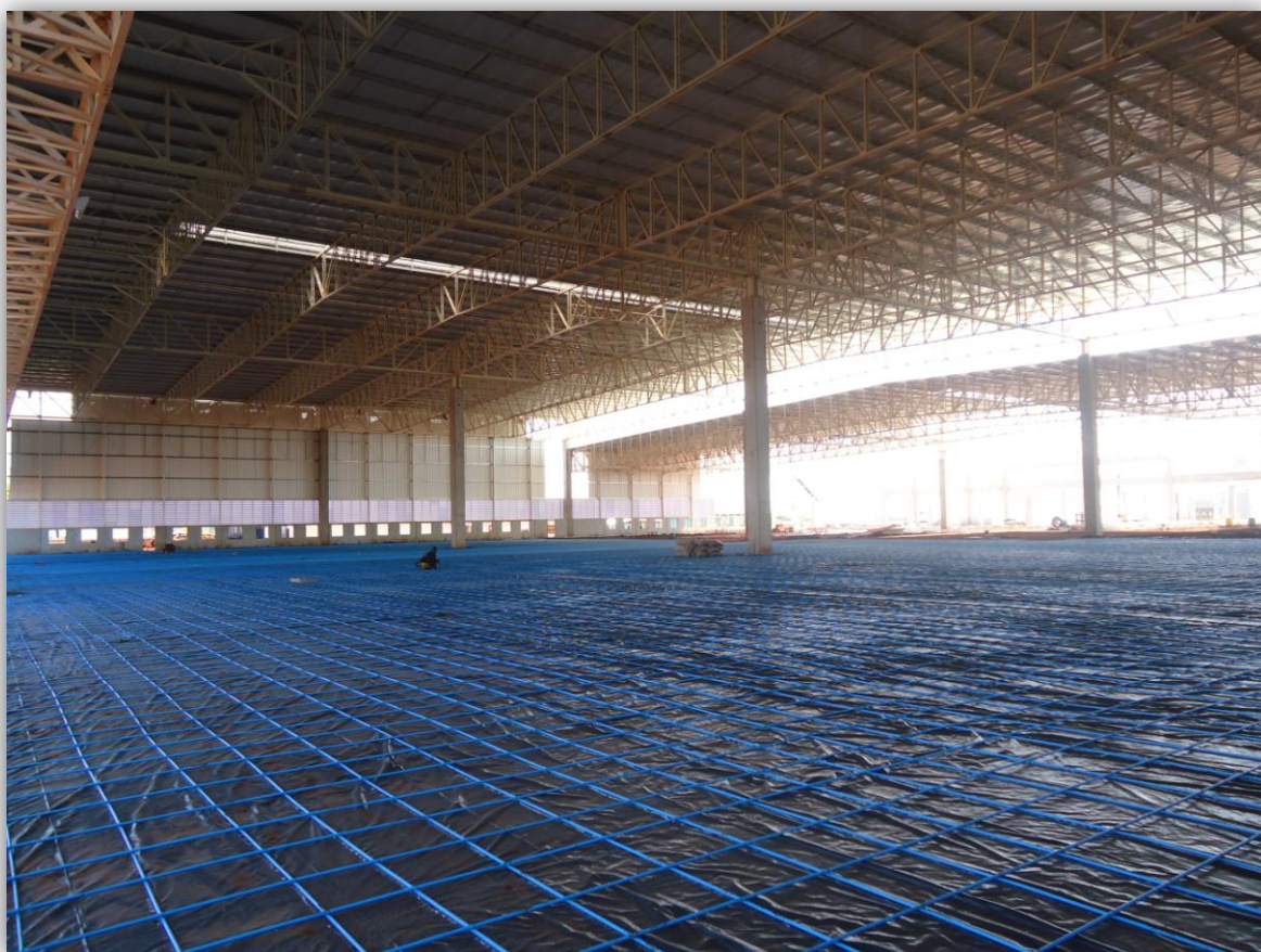
Fig. 46 – Vista de uma pista com cabos de protensão (Fonte: Própria)
