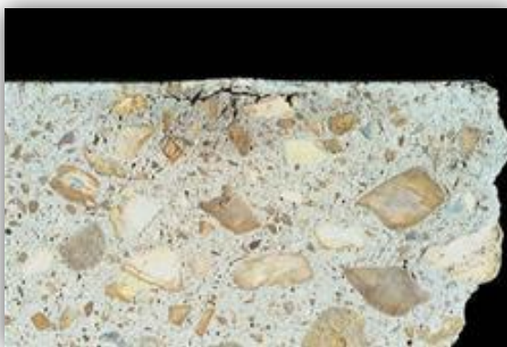
Fig- 63 - Corte de um piso com formação de bolha. (Fonte: PCA apud SEEGBRECHT, 2013)
