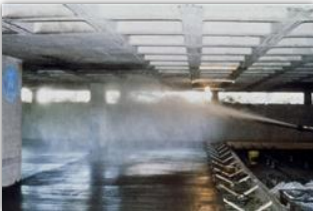
Fig. 73 - Spray para aumentar umidade relativa. (Fonte: PCA apud. SEEGEBRECHT, 2013)
