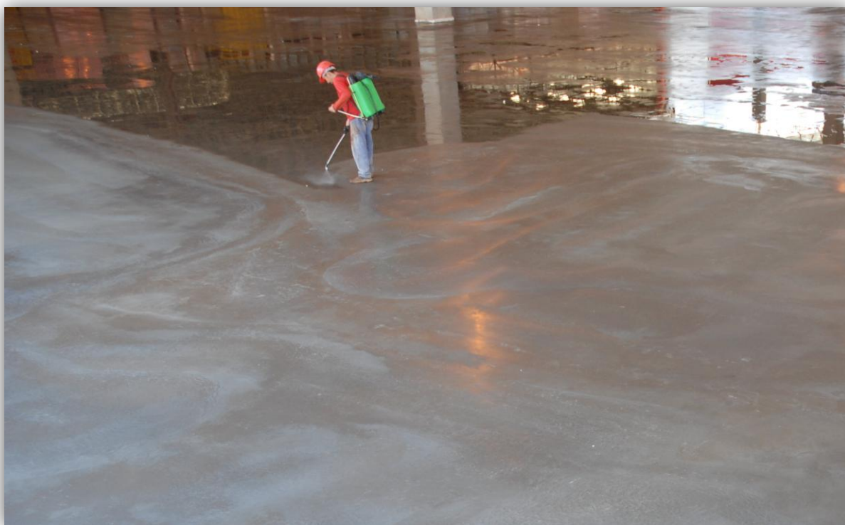
Fig. 60 – Aplicação de cura química (Fonte: Própria)
