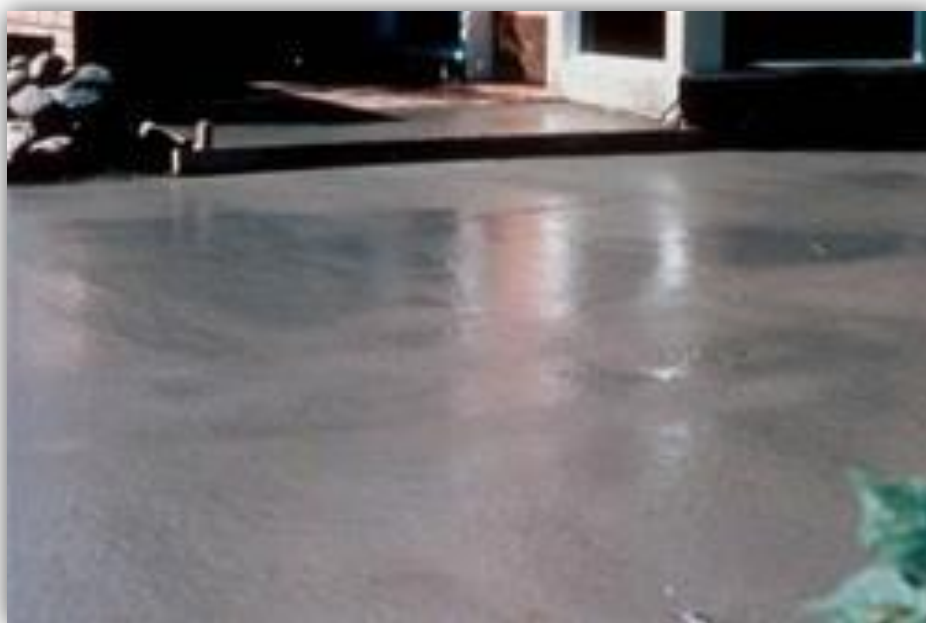
Fig. 72 - Brilho característico da água de exsudação. (Fonte: Cortesia de PCA apud SEEGBRECHT, 2013)
