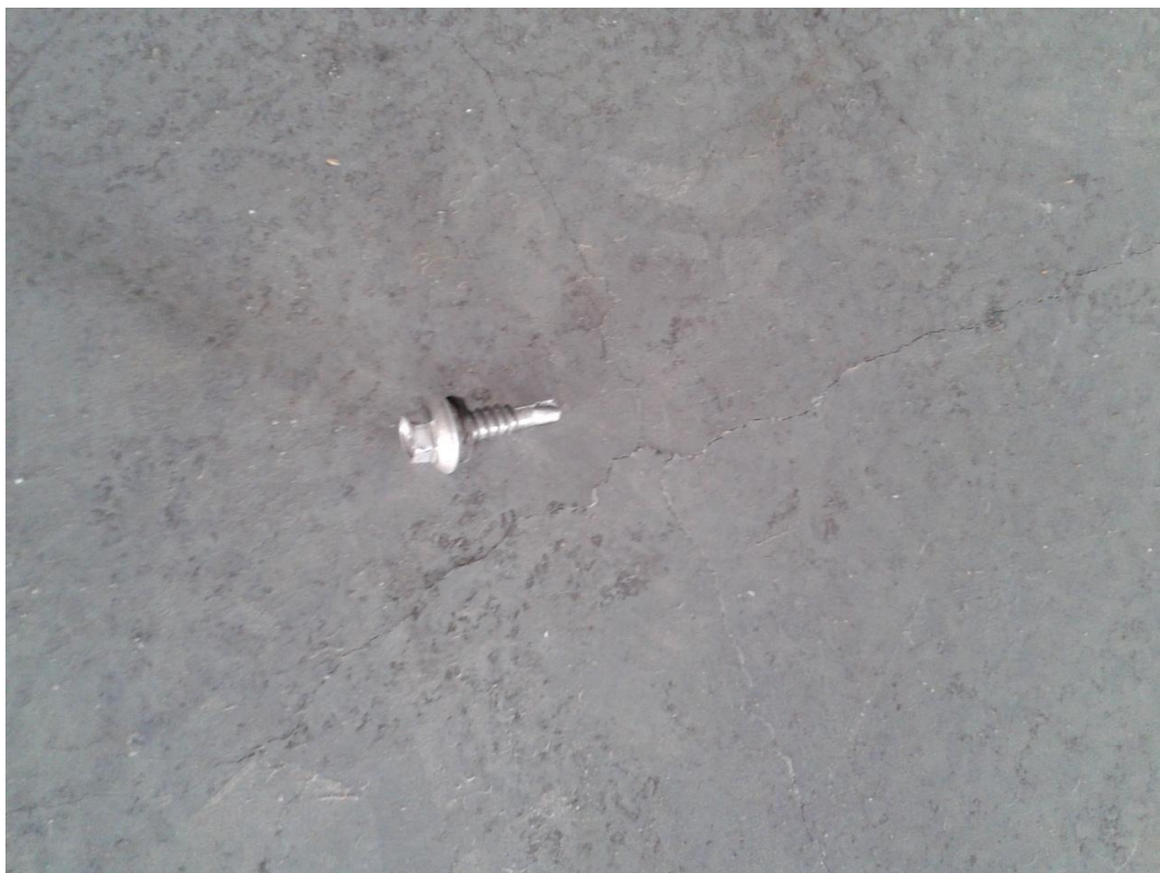
Fig. 76 – Interseção entre fissuras (Fonte: Própria)
