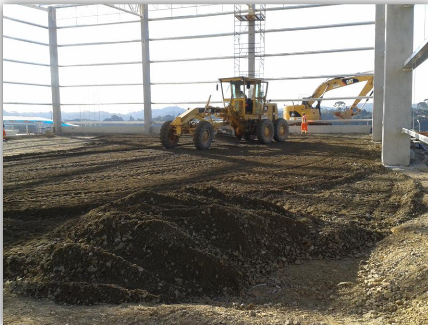
Fig. 34 - Execução de sub-base com material granular (BGS) (Fonte: Própria)
