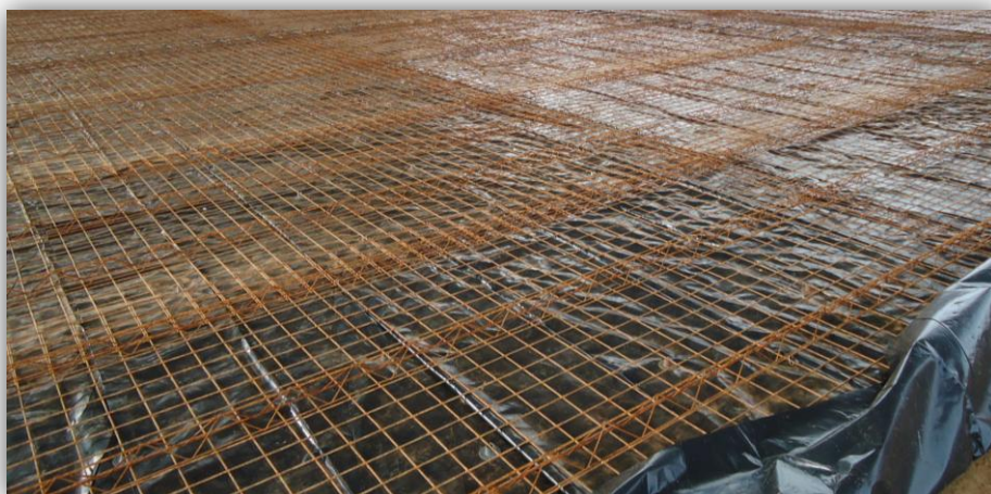
Fig. 40 – Posicionamento de treliças de h=8\text{cm} (Fonte: Própria)
