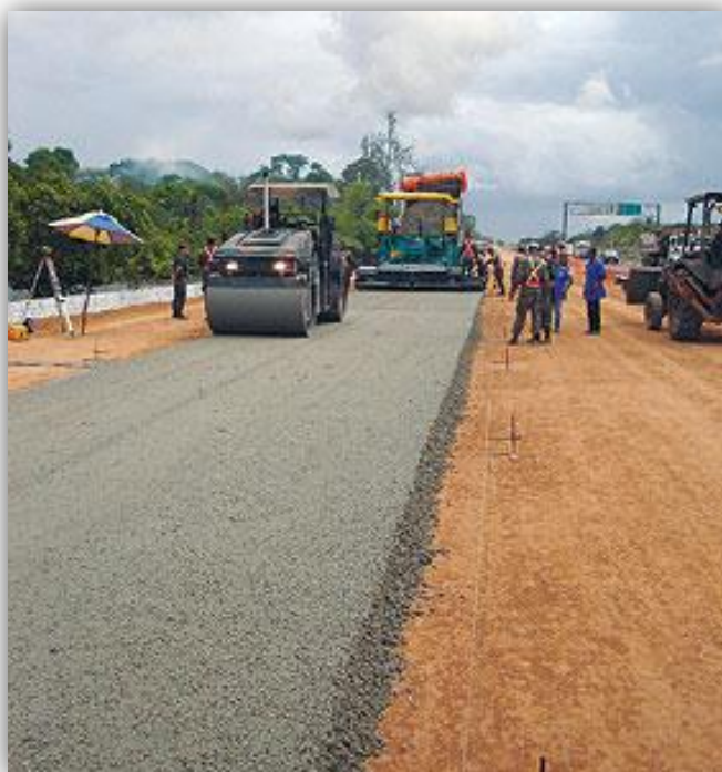
Fig. 37 - Execução de camada de CCR (Fonte: Cimento Itambé) 6
