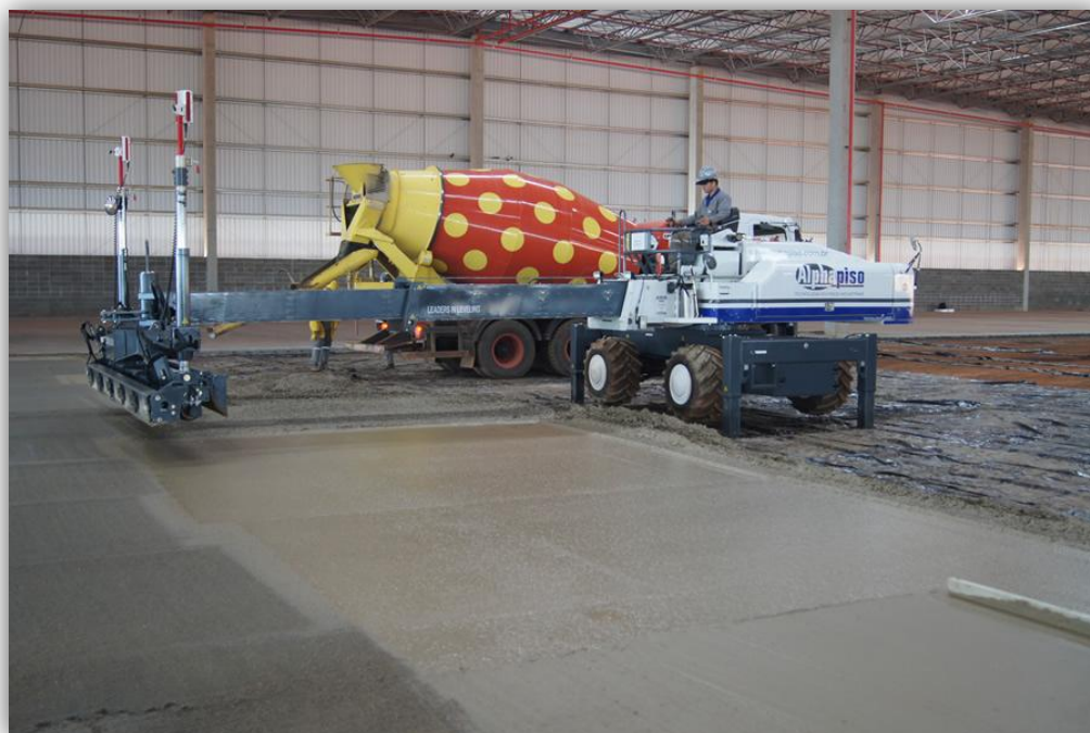
Fig. 57 – Laser Screed (Fonte: Alphapiso 11 )
