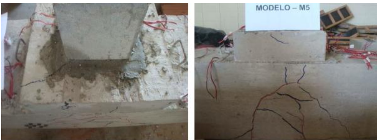
Figura 51: Fissuração do colarinho parcialmente embutido no bloco de fundação Fonte: Barros, 2009.
