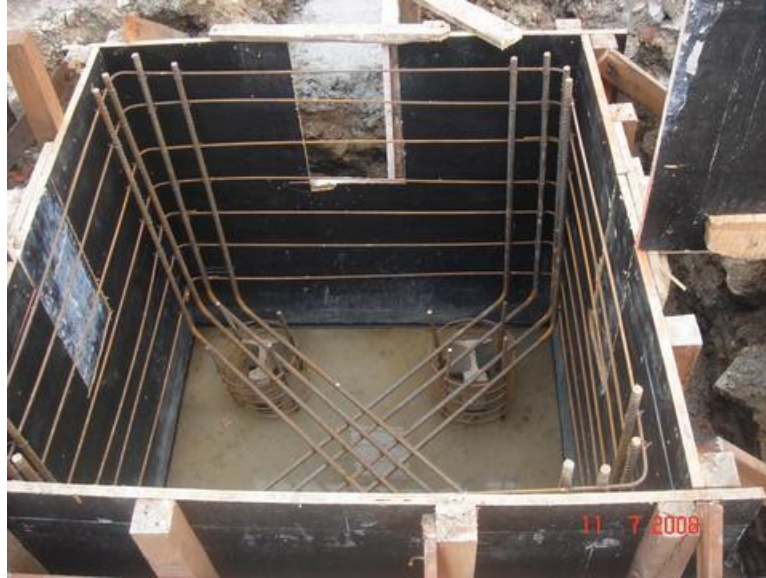
Figura 11: Espirais de fretagem para ligação do bloco com as estacas
