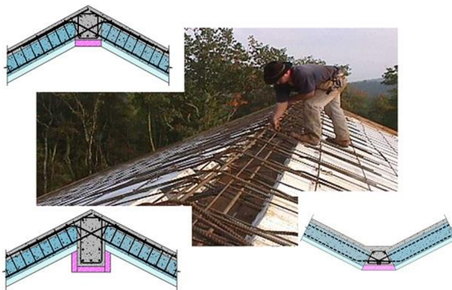
Figura 36: Arranjos das armaduras para desvios de esforços longitudinais Fonte: http://tornadoproofhouses.com/roofs.php .
