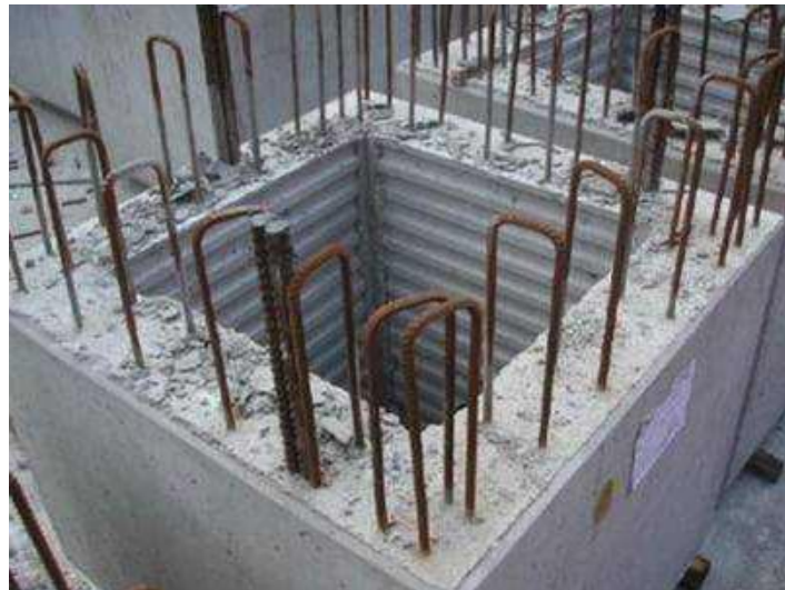
Figura 47: Colarinho rugoso para pilar de concreto pré-fabricado
