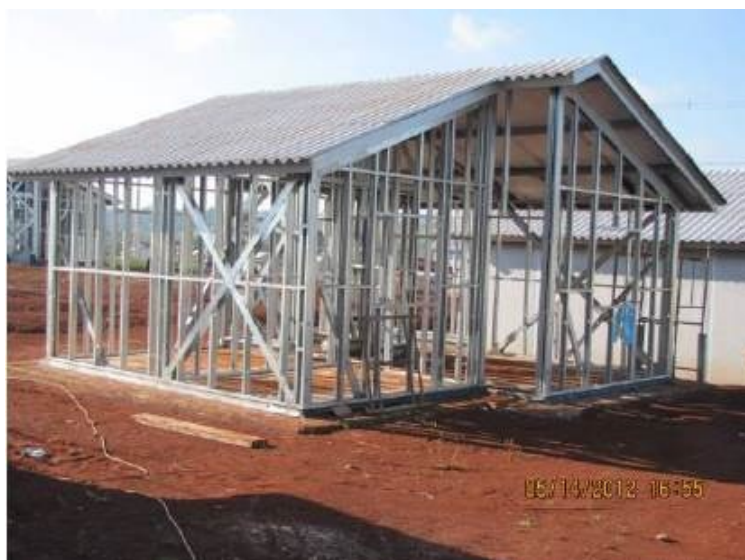
Figura 8 – Unidade em construção, com a estrutura LSF montada Fonte: DATEC 014
