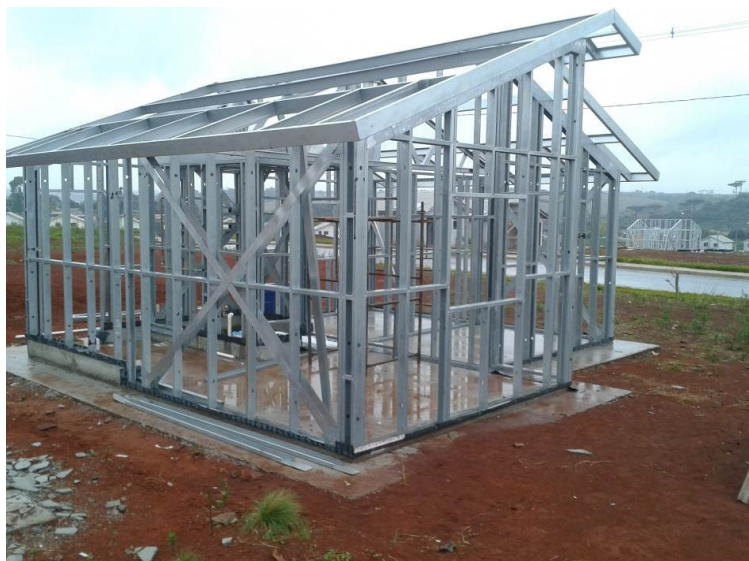
Figura 10 – Estrutura em LSF sendo montada. Fonte: Autor
