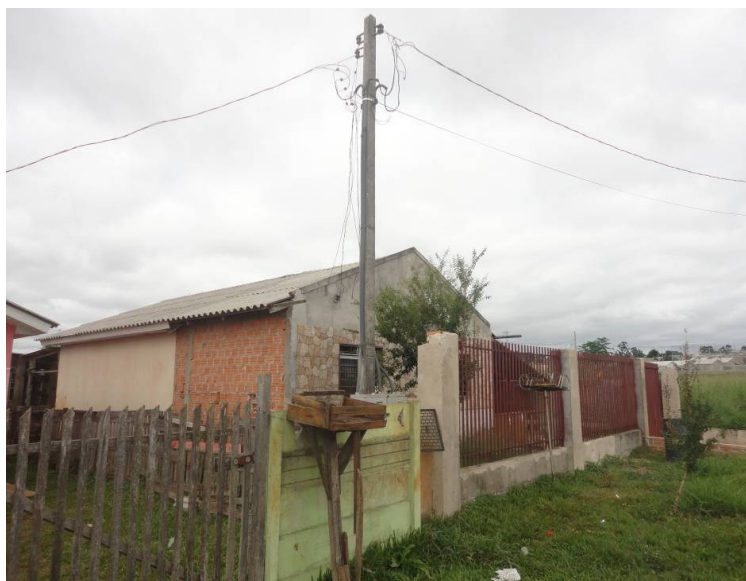
Figura 16– Unidade habitacional com ampliação do corpo da edificação Fonte: Autor (2017)
