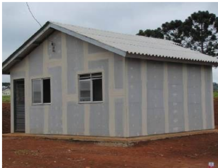
Figura 9 – Unidade com a vedação externa em placas cimentícias em execução. Fonte: DATEC 014
