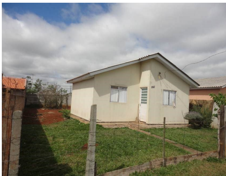
Figura 17- Unidade habitacional com substituição na porta de entrada Fonte: Autor (2017)
