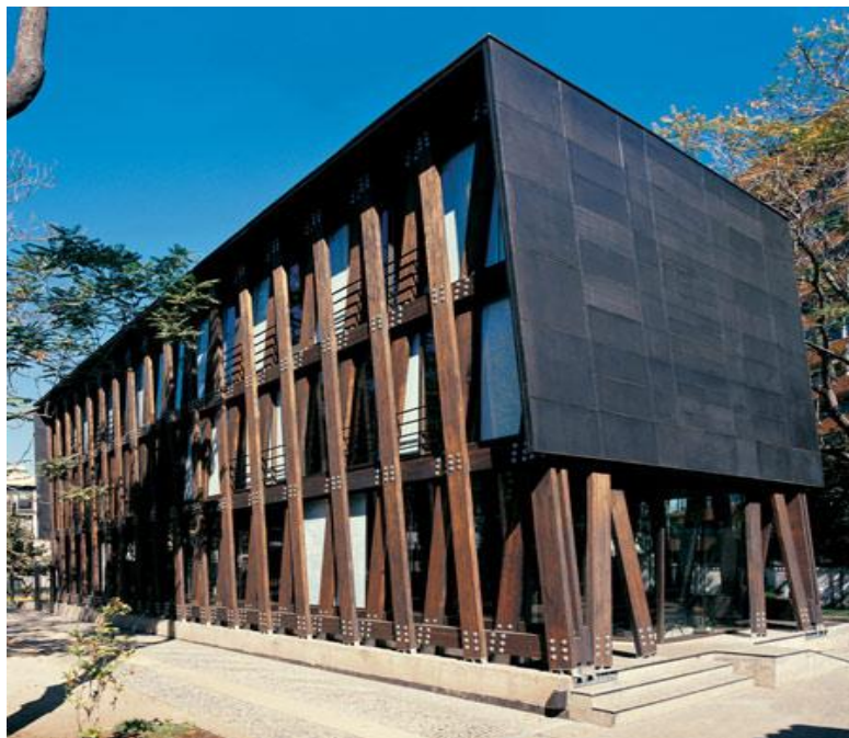
Figura 47 – Edifício BIP. Santiago/Chile. Vista externa. Fonte: OMELETE, 2008.
