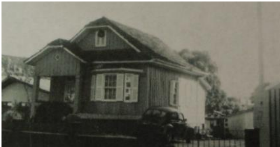
Figura 40 – Residência localizada na Rua Alberto Folloni, 815- Ahú – Curitiba-PR Fonte: JUNIOR et al., 2001.
