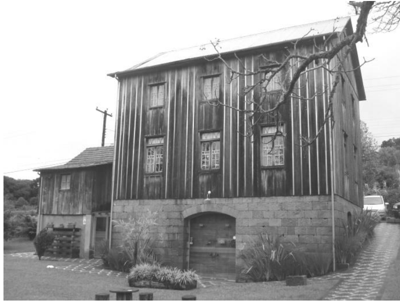
Figura 24 – Casa Vanni – Caminhos de Pedra São Pedro/Bento Gonçalves-RS. Fachada posterior. Fonte: acervo da autora.
