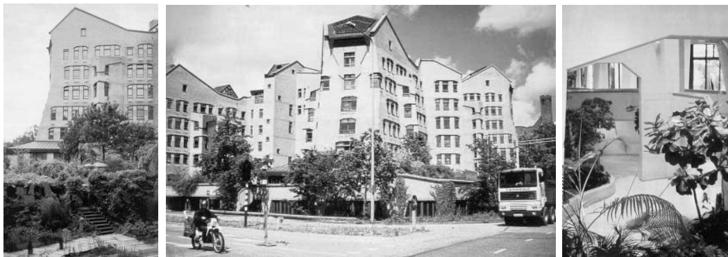
Figura 6 - Banco NMB, Amsterdã – Holanda. Aspectos externos e interno. Fonte: BROWNING, 1992.
