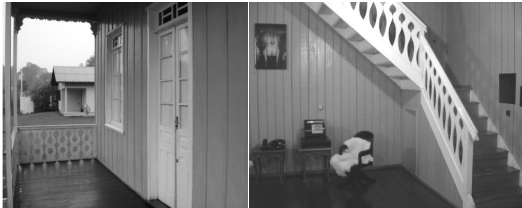
Figura 19 – Casa da Ovelha – Detalhes da varanda e escada. Fonte: acervo da autora.
