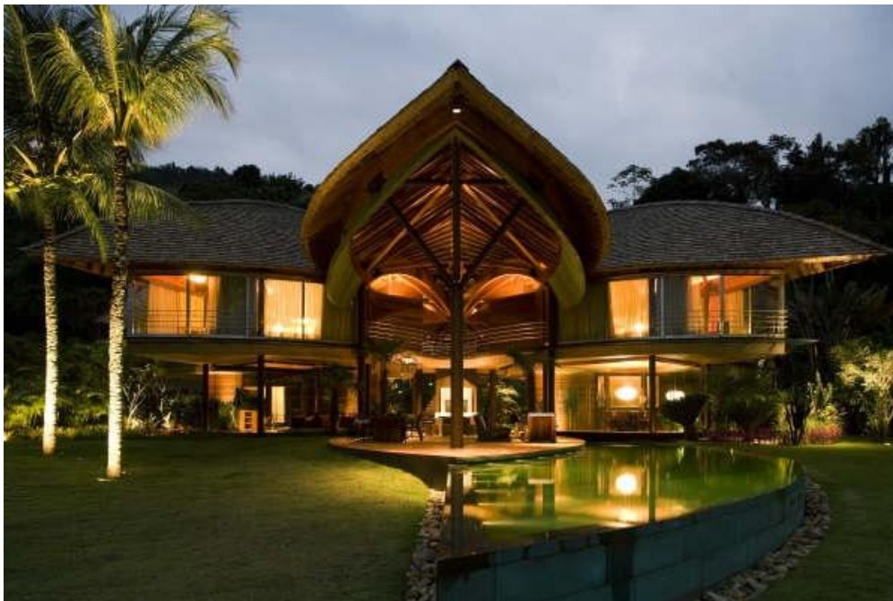
Figura 49 – Casa Folha. Angra dos Reis/RJ. Fonte: ESTRUTURAS DE MADEIRA, 2008.
