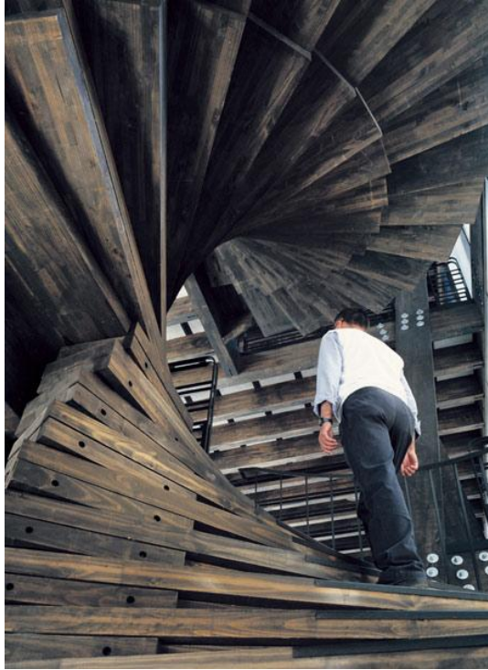
Figura 48 – Edifício BIP. Santiago/Chile. Detalhe construtivo da escada. Fonte: OMELETE, 2008.
