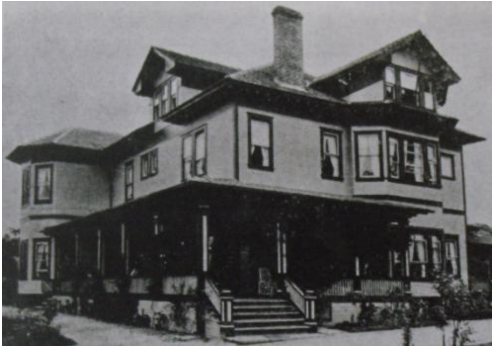
Figura 36 – Residência da família Gomm construída no bairro Batel em 1913 – Curitiba-PR Fonte: SUTIL, 2002.
