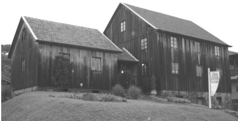
Figura 20 – Casa da Tecelagem – Caminhos de Pedra São Pedro/Bento Gonçalves-RS Fonte: acervo da autora.
