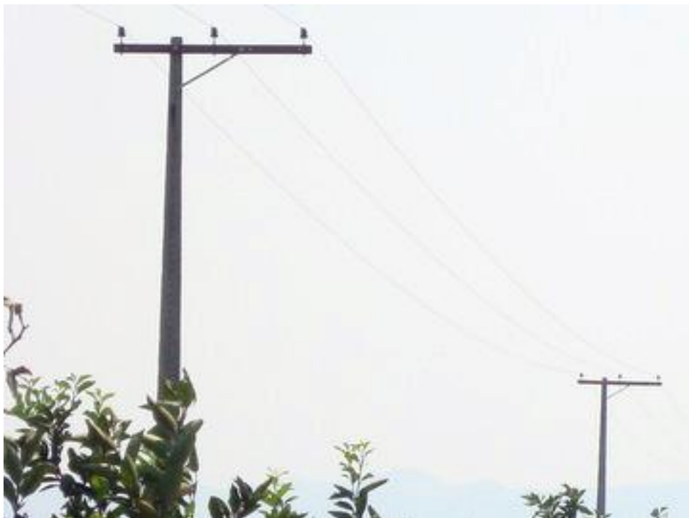
Figura 7 – Rede de Distribuição Aérea Convencional
