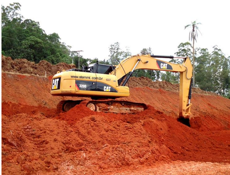
Figura 5 - Escavadeira trabalhando em material de 1ª categoria Fonte: ARAMOV (2015)
