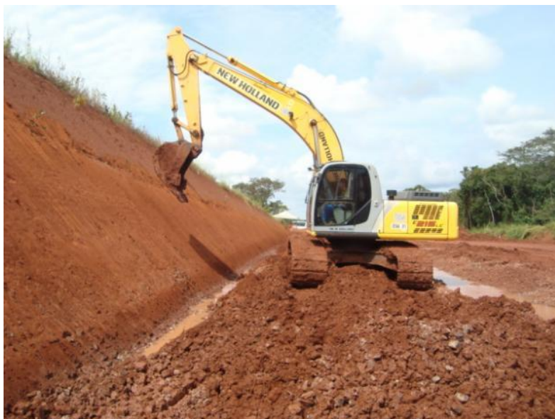
Figura 4 - Escavadeira dando acabamento em talude de corte Fonte: ARAMOV (2015)
