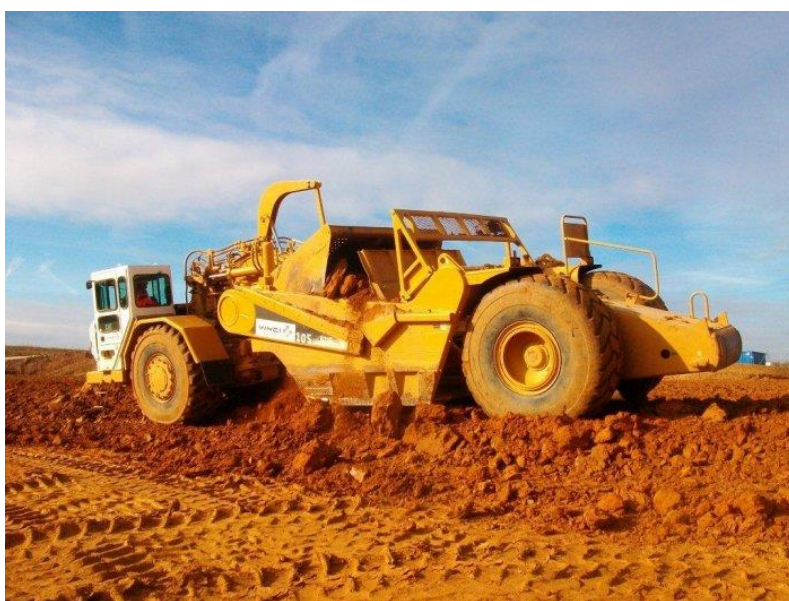
Figura 3 - Motoscraeper descarregando Fonte: Página do sítio The Construction, 2015
