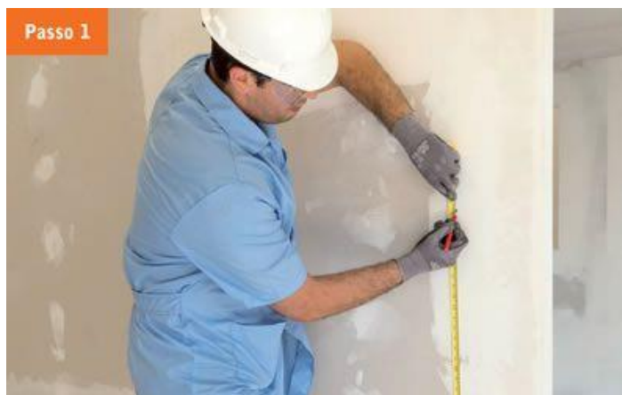
Figura 2 - Locação das caixas de passagem
