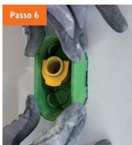
Figura 5 - Locação e fixação de eletroduto.
