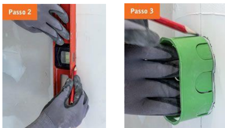
Figura 3 - Marcação nivelada e alinhada para corte de gesso
