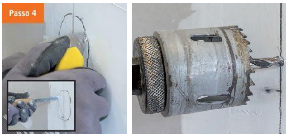
Figura 4 - Corte de gesso acartonado.
