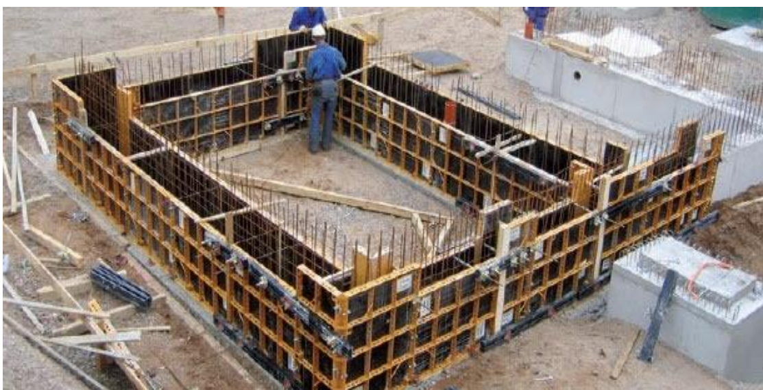
Figura 3 – Montagem das formas Fonte: JORNAL, O Sul, 2015;
