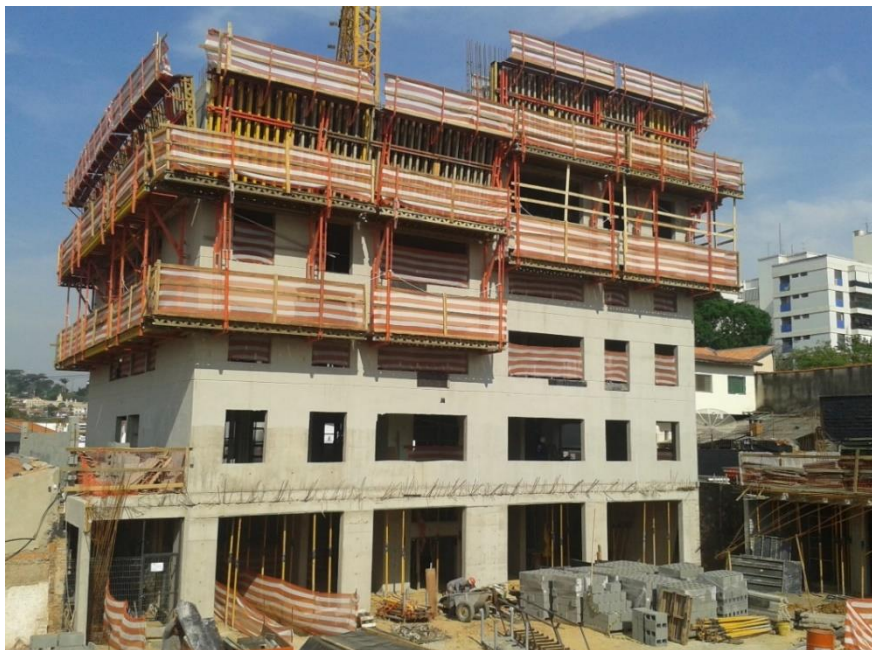
Figura 5 – Edificação utilizando o Sistema Paredes de Concreto Fonte: OLIVEIRA e OLDAKOSKI, 2014;
