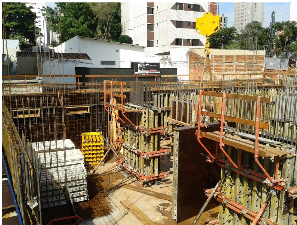
Figura 4 – Exemplo de içamento das formas. Fonte: OLIVEIRA e OLDAKOSKI, 2014;
