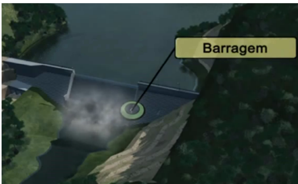
Figura 2.2 – Detalhe da barragem nas ombreiras e ao cento a estrutura do vertedouro.
