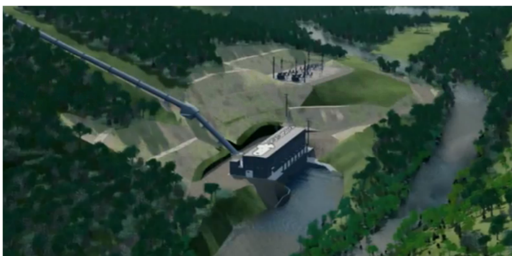
Figura 2.7 – Detalhe da casa de força.
