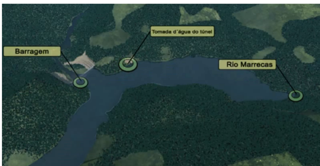
Figura 2.1 – Vista aérea do reservatório, barragem, vertedouro e tomada d' água.
