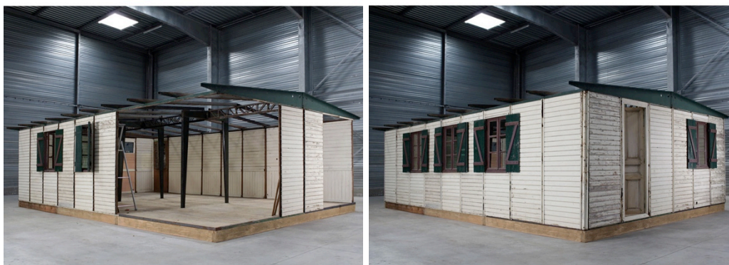
Figura 2: Casa desmontável 6x9m, 1944, Metal e madeira. Fonte: Galerie Patrick Seguin. Disponível em < http://www.patrickseguin.com >. Acesso em 22 fev. 2014.
