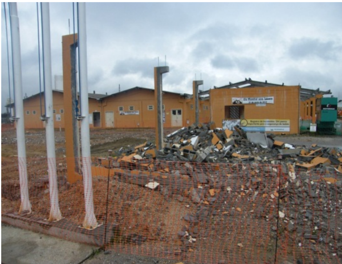
Figura 4: Estrutura de concreto pré-moldado com alvenaria de vedação de blocos de concreto sendo demolida. Fonte: A Autora, 2012.
