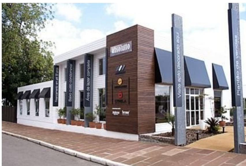
Figura 15: Stand de vendas construído com o sistema Quick House. Fonte: Quick House (QUICKHOUSE, 2014).
