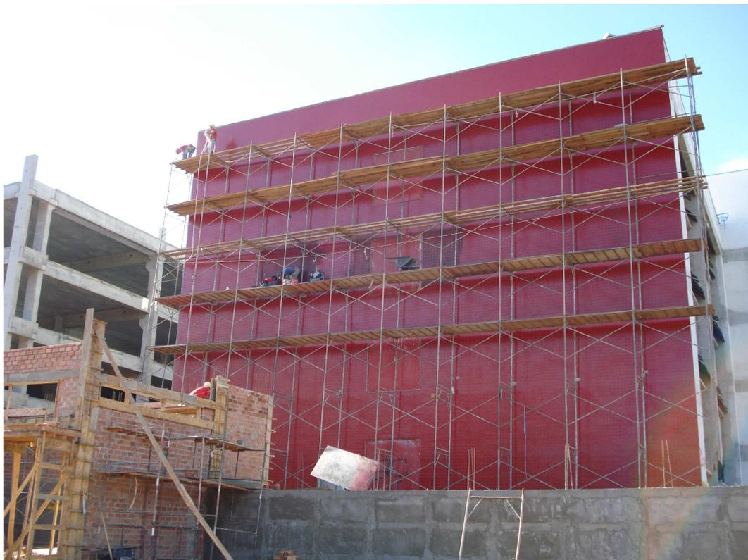
Figura 6 - Processo de revestimento, bloco N, Sede Ecoville.
