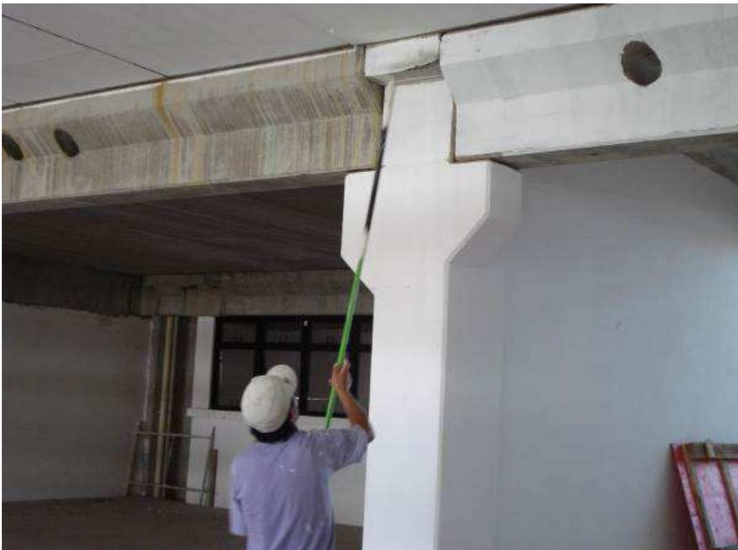
Figura 9 - Execução de pintura interna com tinta acrílica.
