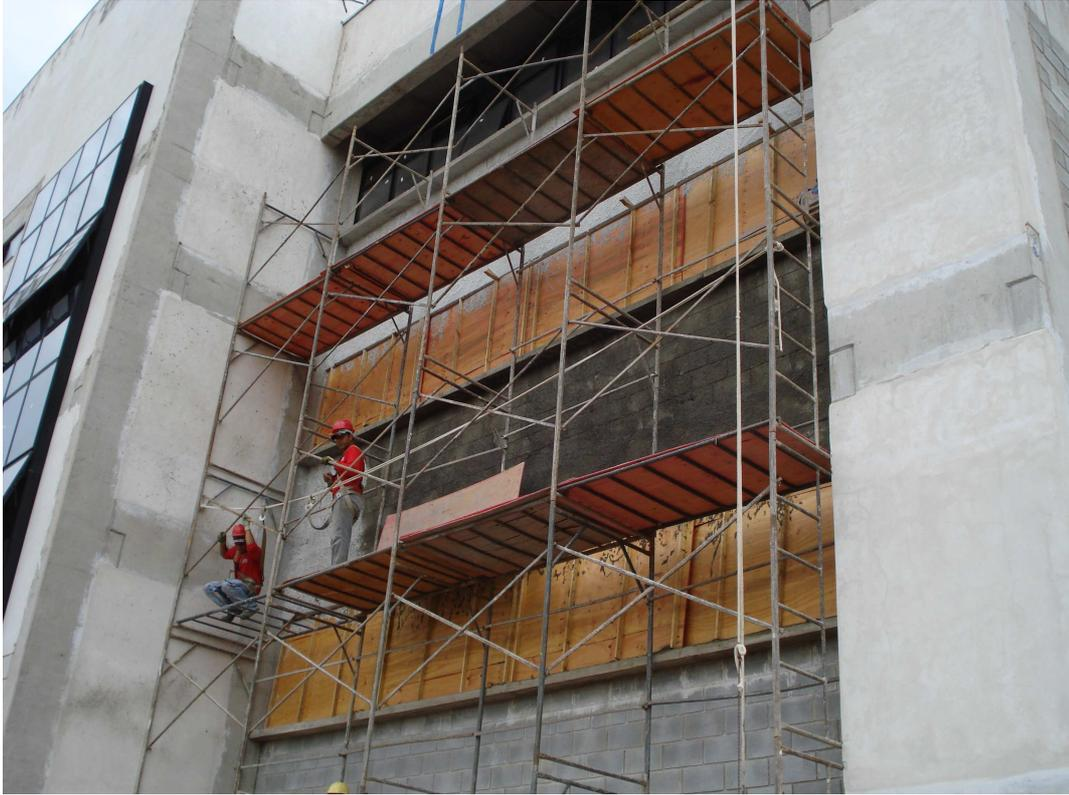
Figura 7 - Processo de execução do substrato, Bloco N, Sede Ecoville.
