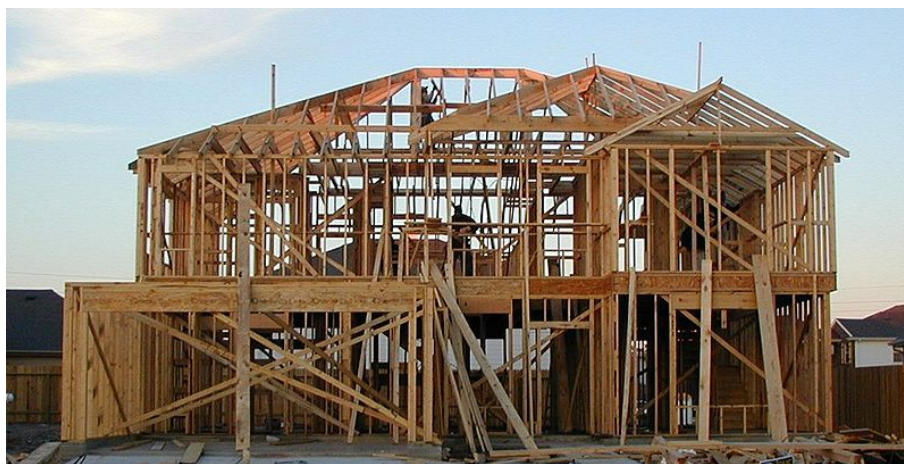
Figura 4: Construção de casa pré-fabricada de madeira com utilização do sistema plataforma (Fonte: http://wikipedia.org/ )
