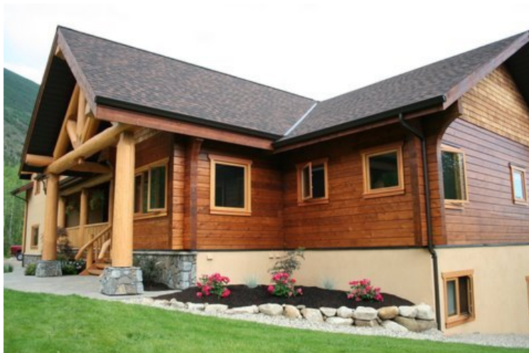
Figura 3: Casa pré-fabricada de madeira com utilização do sistema Log (Fonte: http://portuguese.alibaba.com )
