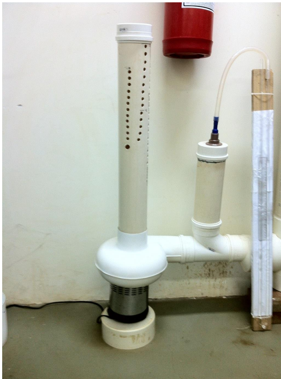
Figura 18 - Fotografia do soprador de ar, e o manômetro de tubo em “U” Fonte: Autoria própria.
