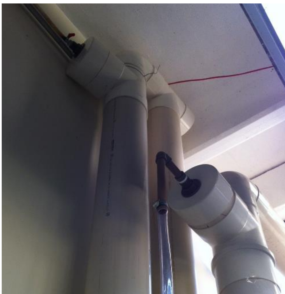
Figura 17 - Fotografia da torre de air stripping , vista da parte superior Fonte: Autoria própria.
