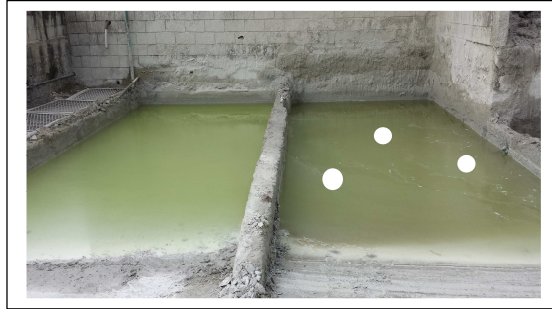
Figura 6 - Pontos de coleta - lastro de concreto Fonte: O autor, 2015.
