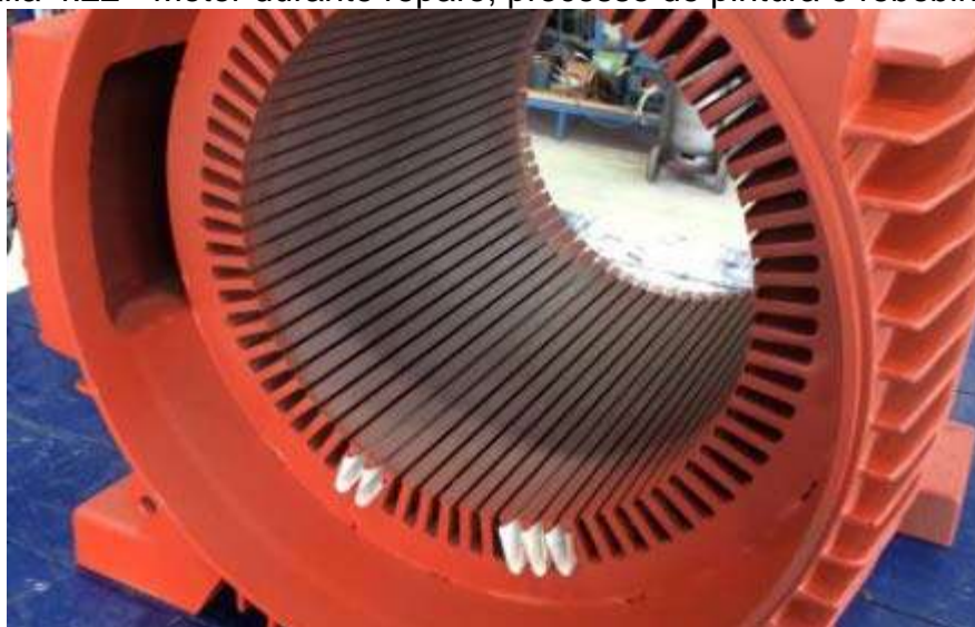
Fotografia 4.22 - Motor durante reparo, processo de pintura e rebobinamento.
