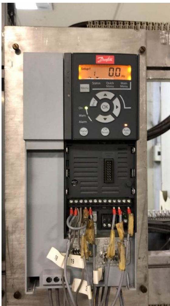
Figura 6 – Inversor de Frequência Danfoss FC-360 440Vac
