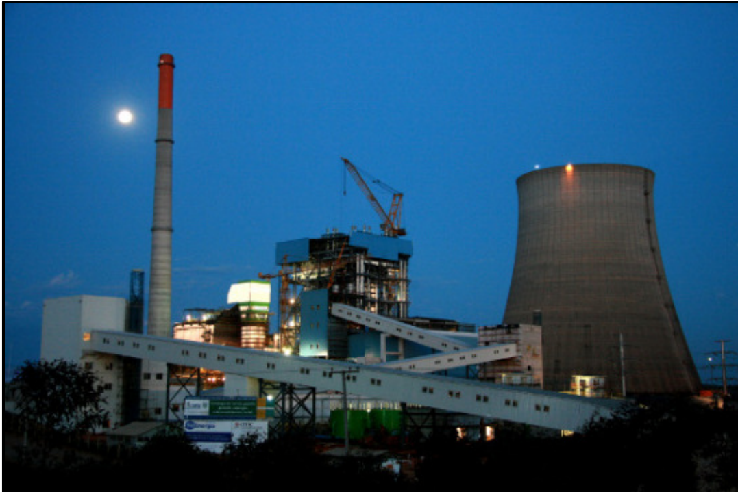
Figura 04 - Usina Termelétrica de Candiota. Fonte: CGTEE, 2015.
