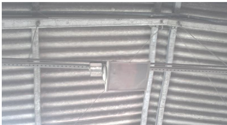
Figura 38 - Luminária com a lente suja Fonte: Autores, 2012
