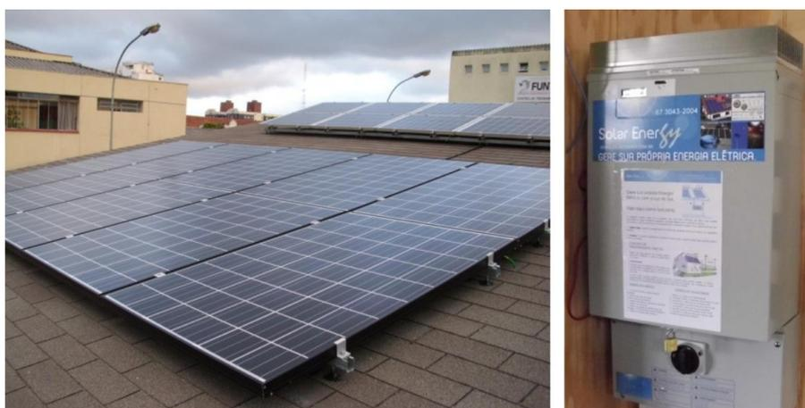
**FIGURA 16 - Painel fotovoltaico e inversor instalados no escritório verde da UTFPR.**
