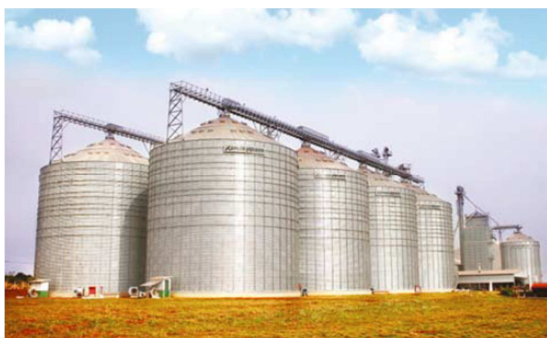
Figura 38 - Silo vertical metálico Fonte: KeplerWeber (2012)
