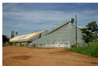
Figura 37 - Armazém graneleiro cúpula Fonte: Rezende (2011)
