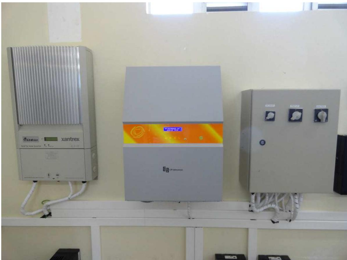
**Figura 10 – Inversores de frequência conectados à rede, instalados na SE Fazenda Iguaçu**
