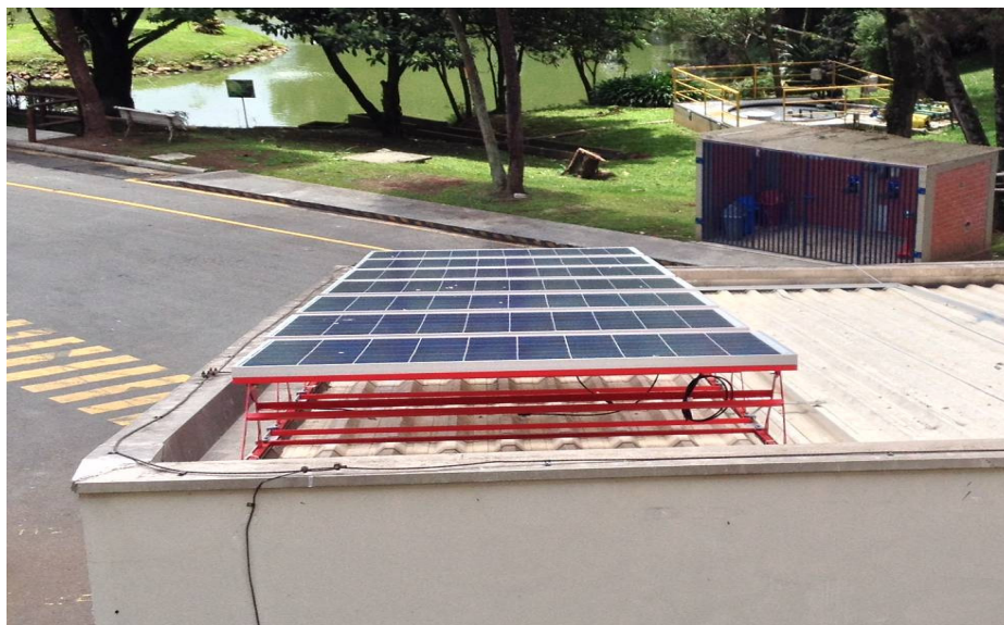
Figura 74: Instalação da planta de geração de energia solar. Fonte: Autoria própria (2013).
