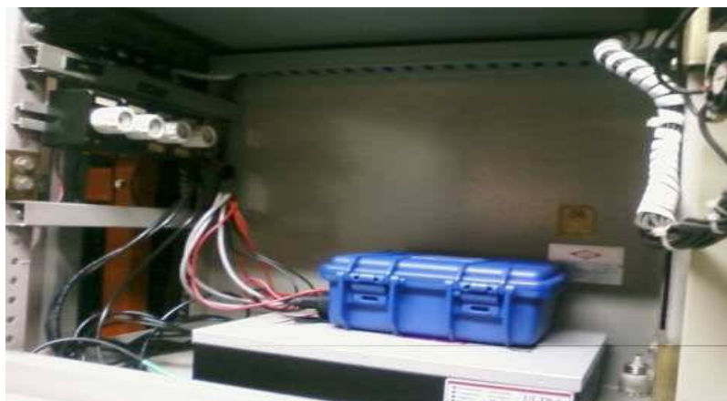
Figura 44: Instalação do equipamento KESECO ULTRA. Fonte: Autoria própria.
