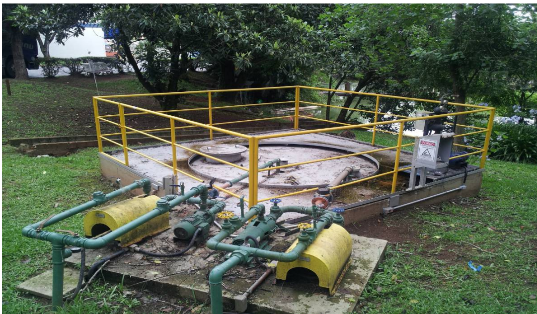
Figura 71: Reutilização da água descartada da ETE para os banheiros da fábrica.
