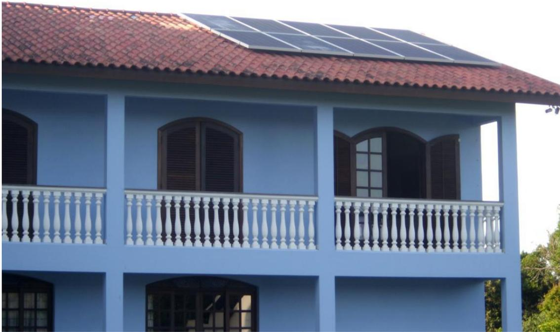
Figura 5: Detalhe dos Módulos Fotovoltaicos na residência de Curitiba
