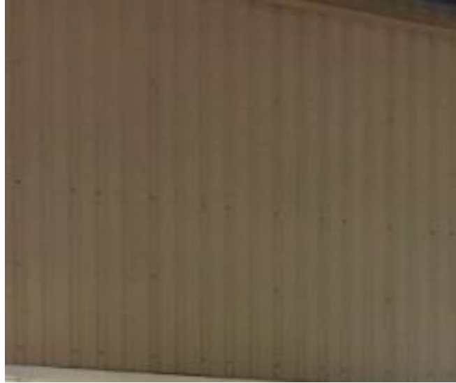
Figura 5 – Vista das paredes laterais
