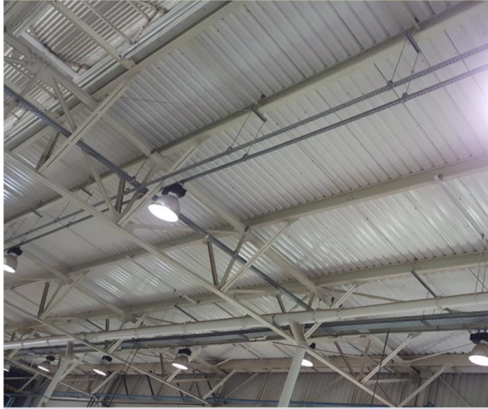
Figura 3 - Vista interna do telhado
