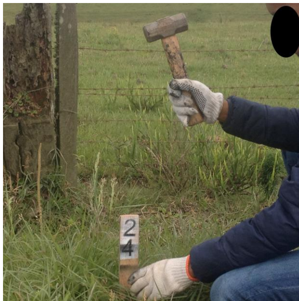
Figura 23 – Auxiliar de topografia II batendo estaca Fonte: Autoria própria (2017)
