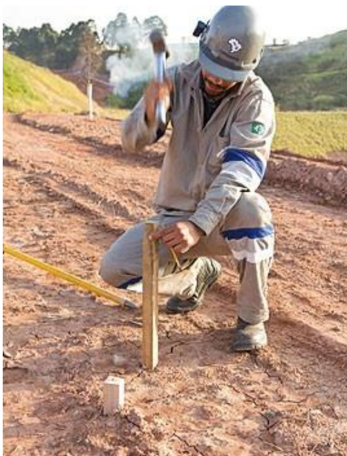
Figura 8 – Batendo Estacas Fonte: Pini (2017)
