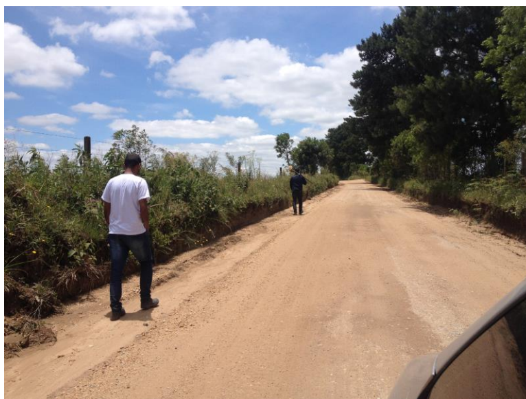
Figura 24 – Auxiliar de topografia II em percurso Fonte: Autoria própria (2017)
