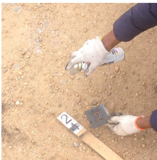
Figura 22 – Auxiliar de topografia II pintura de estaca Fonte: Autoria própria (2017)
